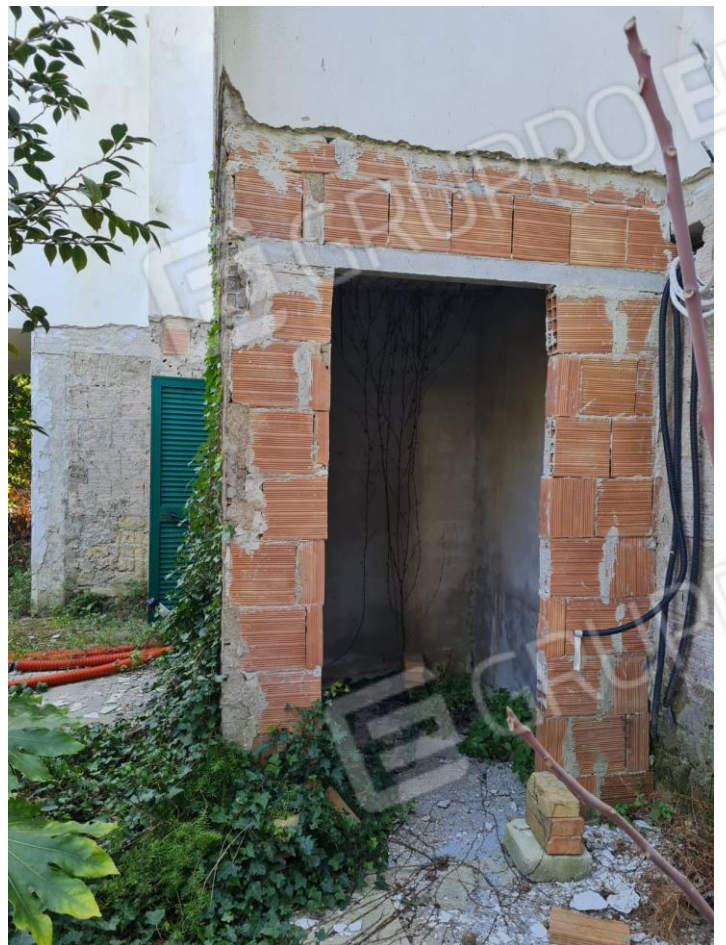
Ripostiglio esterno (R4)
