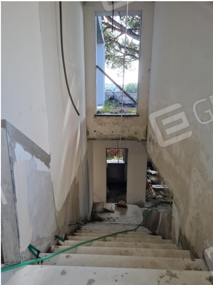
Scala (vista dal piano primo)
