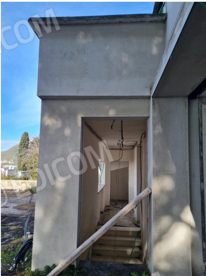
Finestra del vano scala
