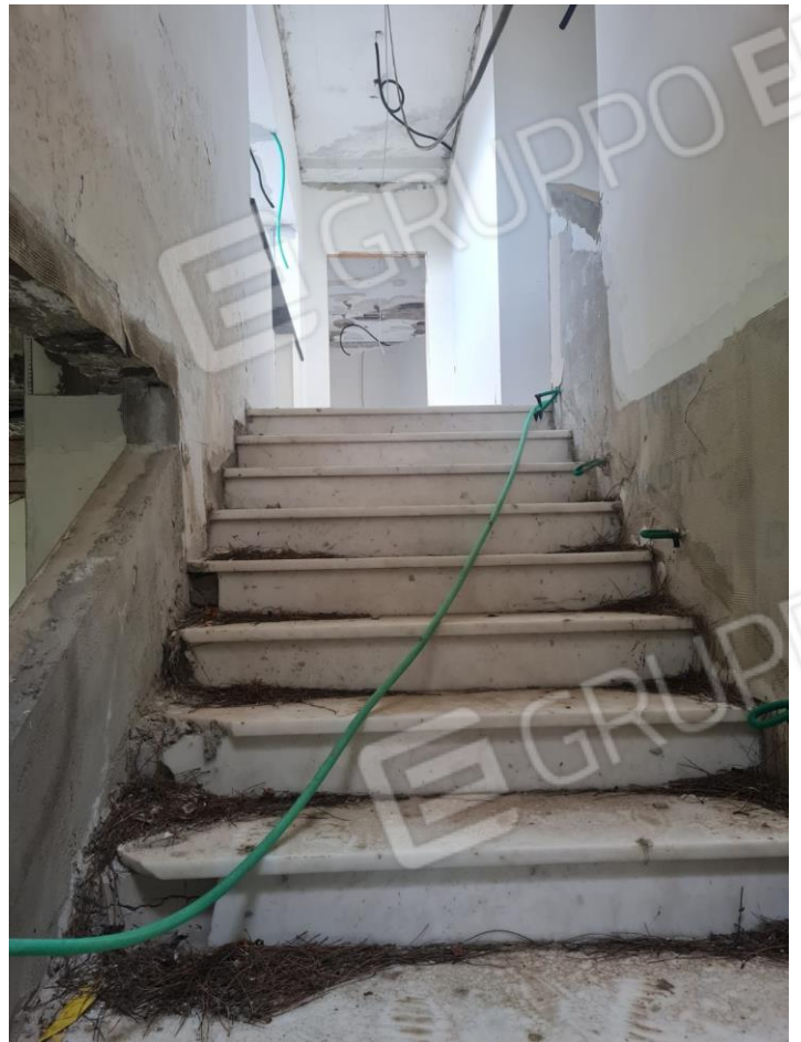
Scala interna di collegamento
