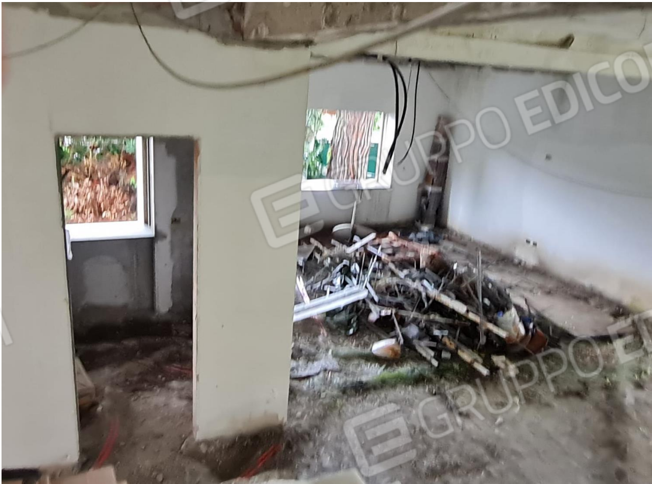
Vano (V1) e bagno (WC1)
