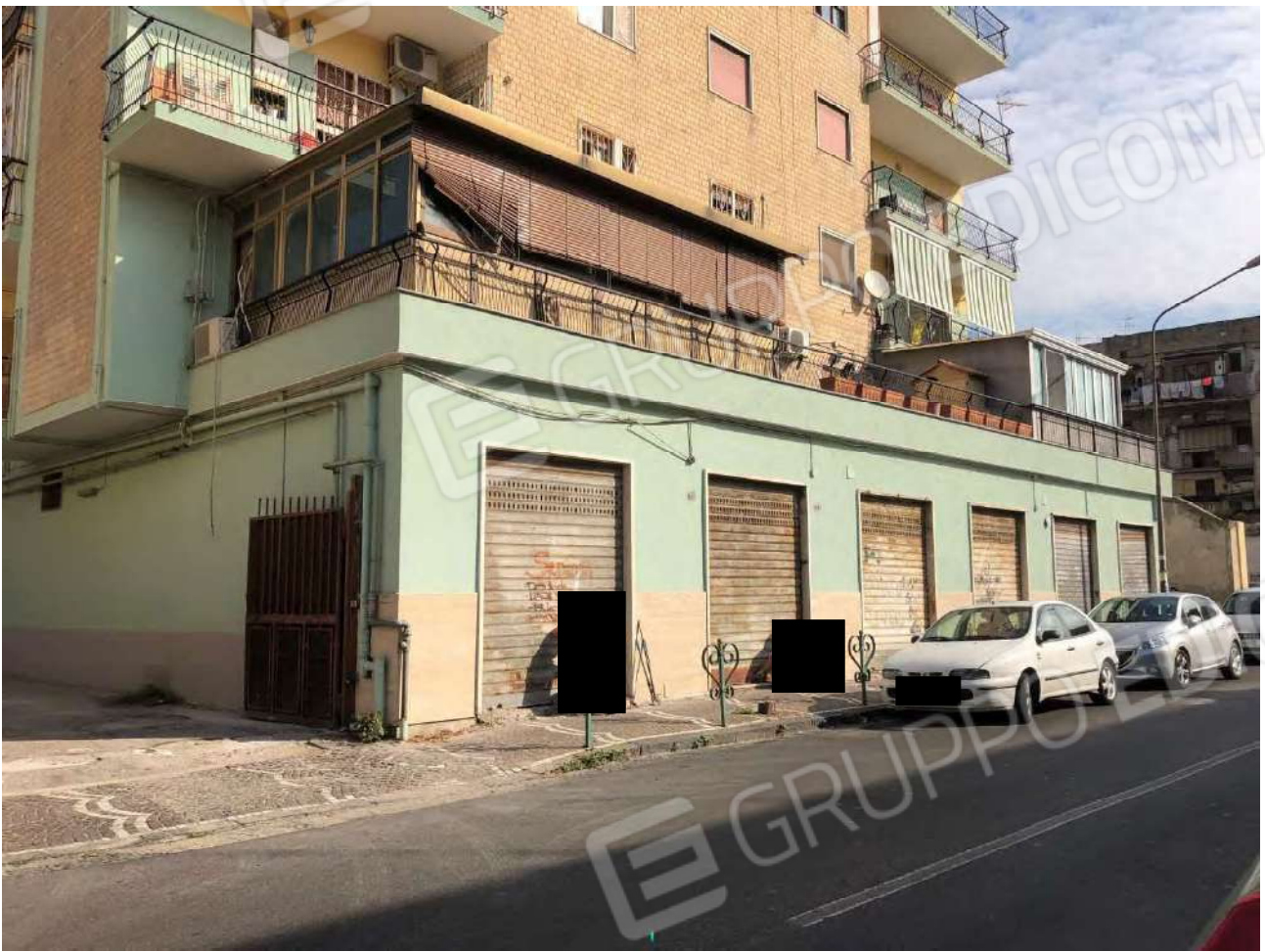
Foto 1 – Vista del fabbricato di corso Protopisani 37, Napoli
