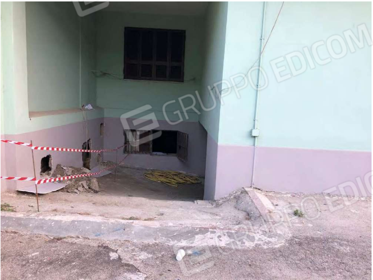
Foto 3 – Vista del piccolo vano di accesso al locale in oggetto
