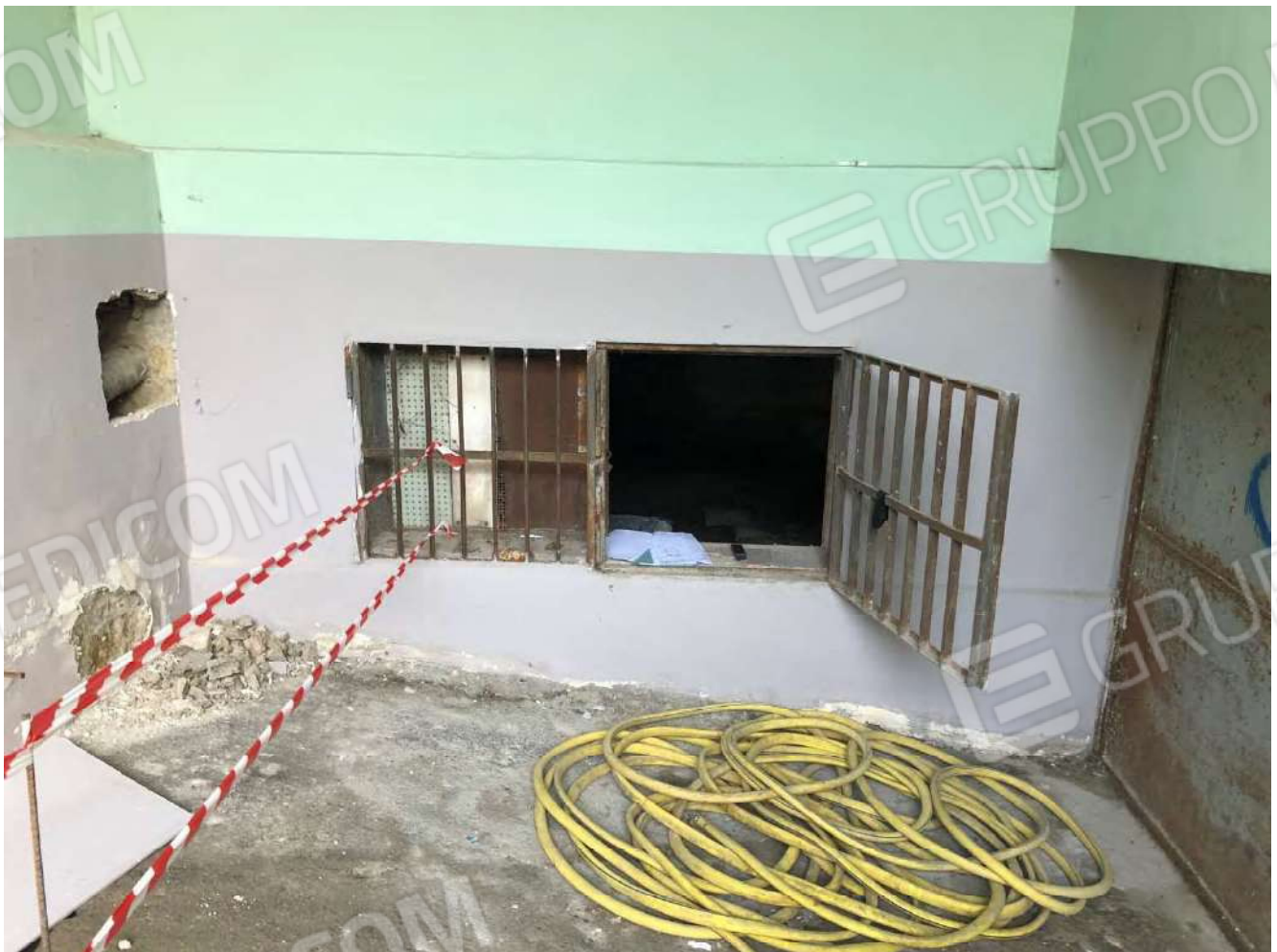
Foto 4 – Vista del piccolo vano di accesso al locale in oggetto
