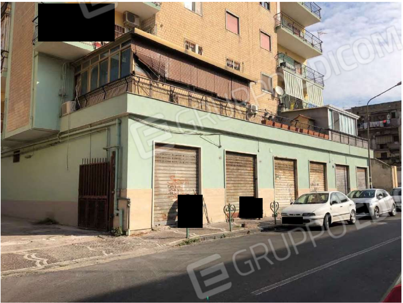
Foto 1 – Vista del fabbricato di corso Protopisani 37, Napoli
