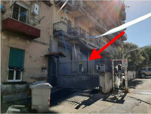
Cancello di ingresso del fabbricato
