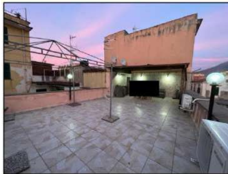
Terrazzo (lastrico solare)
