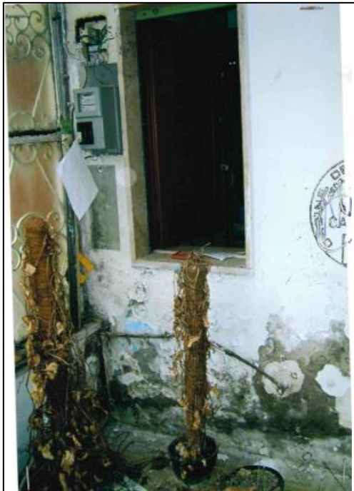
Finestra interna tamponata
