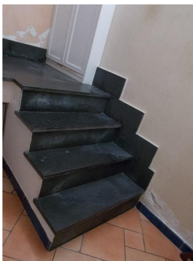
Dettaglio della scala
