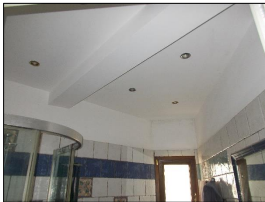
Viste del bagno di servizio
