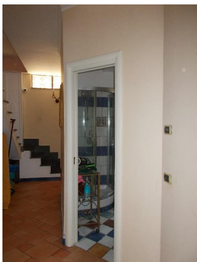
Dettaglio del pavimento
