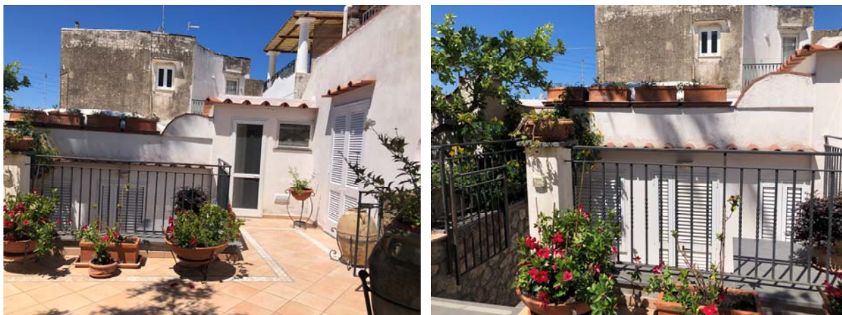
Particolari esterni della dependance
