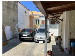
Foto n. 5 - Tettoia dell'immobile - verso l'ingresso
