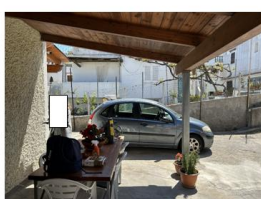
Foto n. 4 - Tettoia dell'immobile - verso l'ingresso
