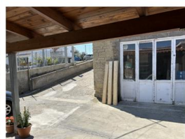
Foto n. 6 - Immobile verso la galleria di proprietà aliena
