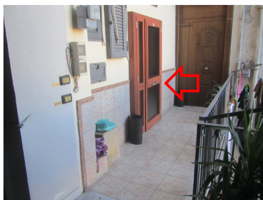
BALLATOIO DI ACCESSO ALL'U.I.
