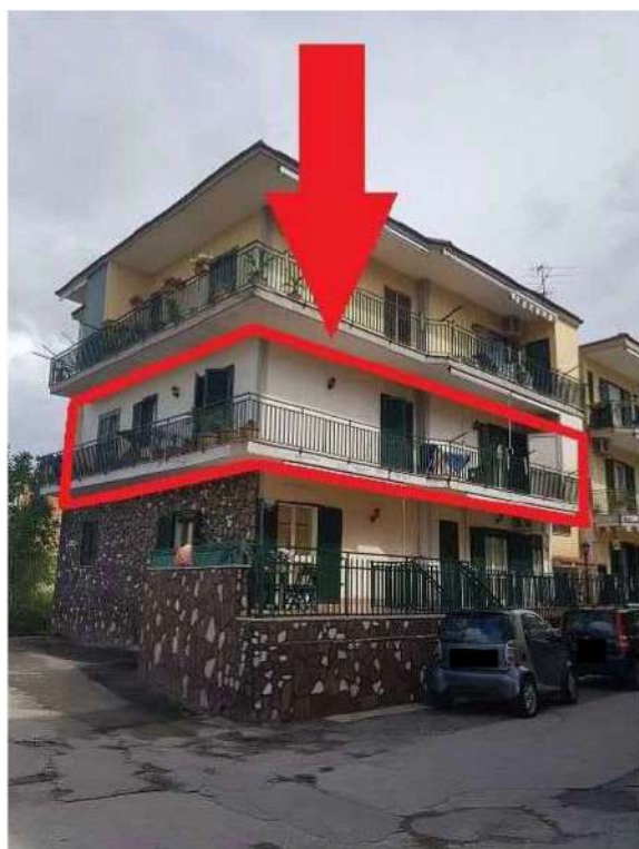
Vista immobile al sub 104
