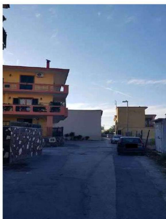
Vista ZONA Casacelle
