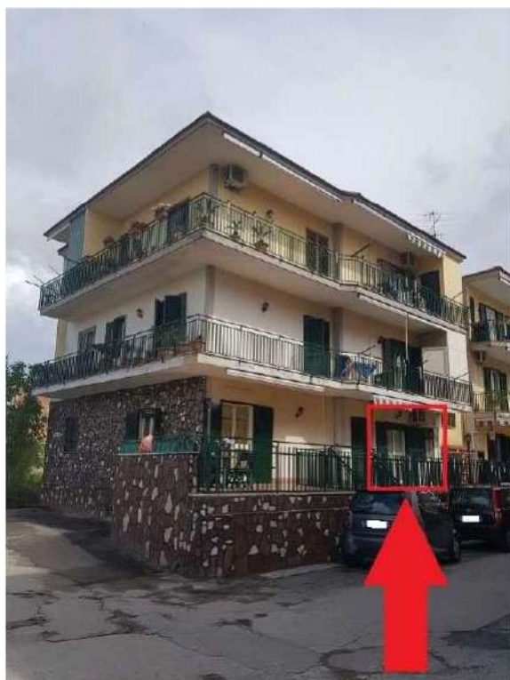
Vista immobile al sub 103
