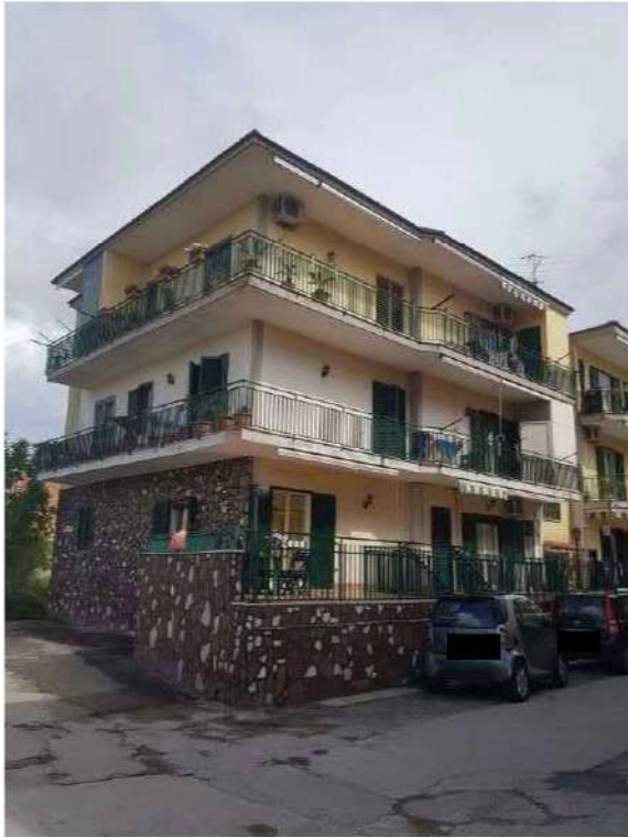
Vista immobile al sub 105
