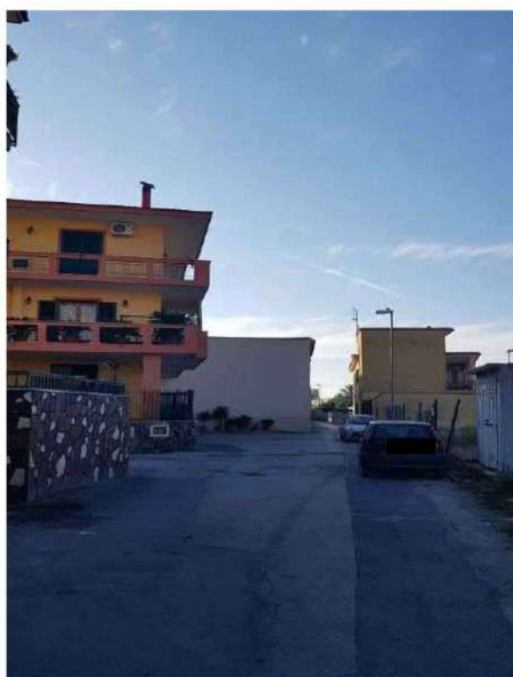
Vista ZONA Casacelle
