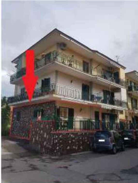
Vista immobile al sub 102
