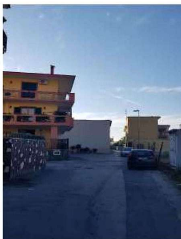
Vista ZONA Casacelle
