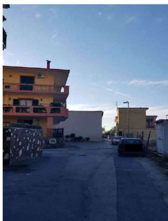
Vista ZONA Casacelle
