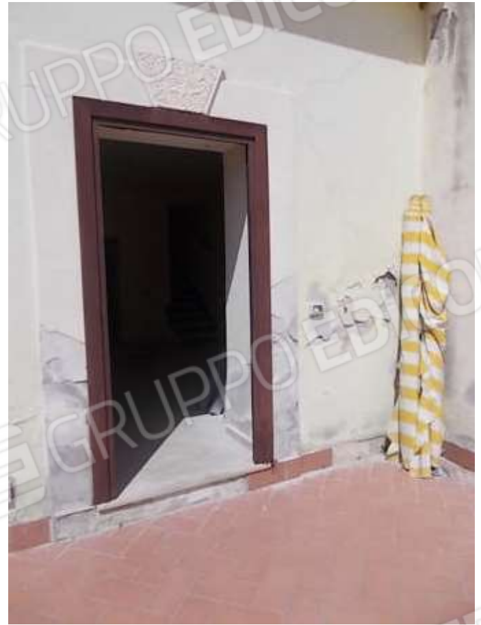
ingresso al bene e terrazzo al piano terra, si rilevano chiazze di umidità ascendente ed infiltrazioni provenienti dalla strada
