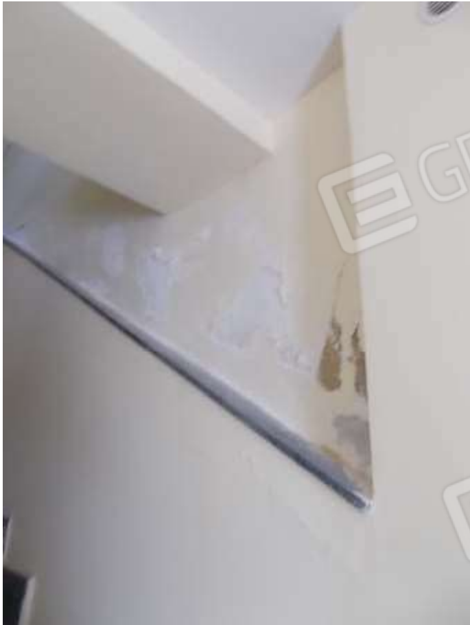
infiltrazioni sulla scala provenienti dal muro di contenimento della strada
