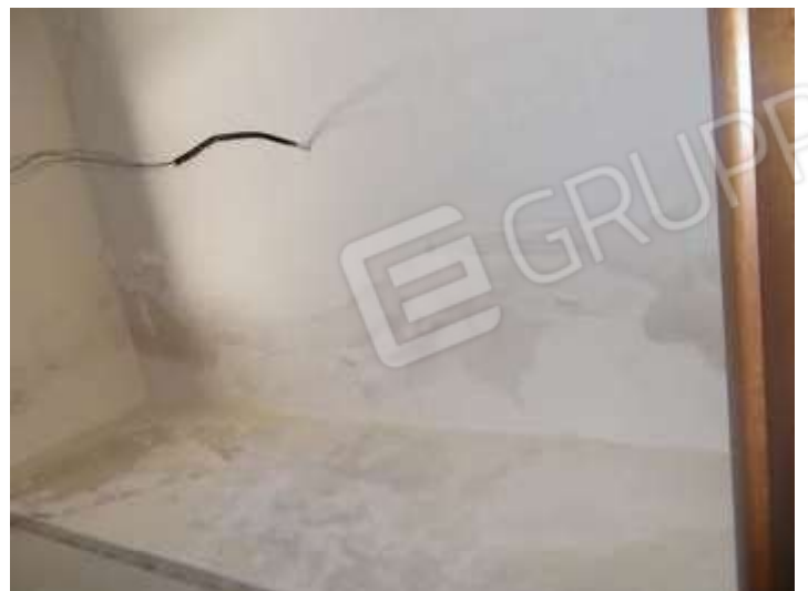
bagno al primo piano, si rilevano infiltrazioni provenienti dalla copertura
