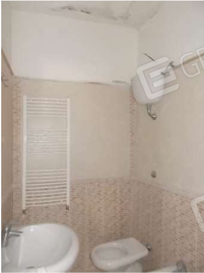
w.c. al piano terra si rilevano infiltrazioni provenienti dal primo piano
