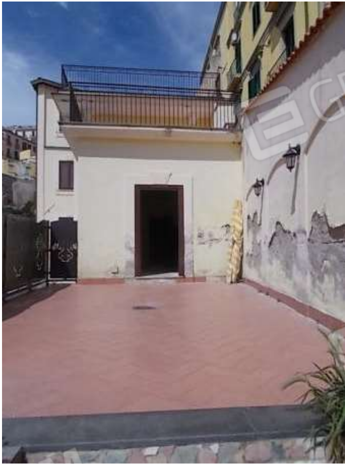
ingresso al bene e terrazzo al piano terra, si rilevano chiazze di umidità ascendente ed infiltrazioni provenienti dalla strada
