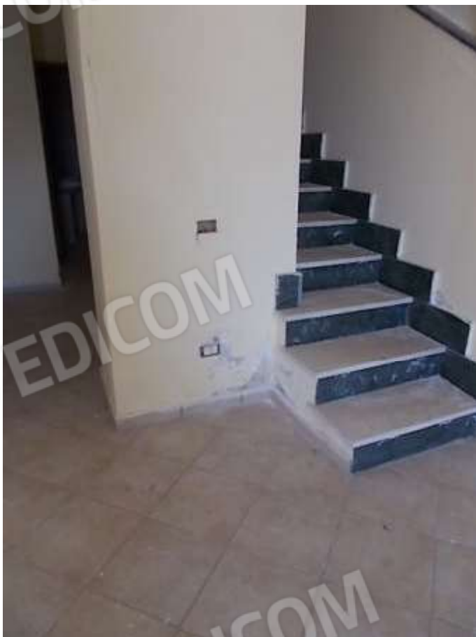
soggiorno - pranzo, si rilevano ampie chiazze di umidità ascendente
