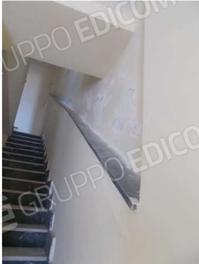
infiltrazioni sulla scala provenienti dal muro di contenimento della strada
