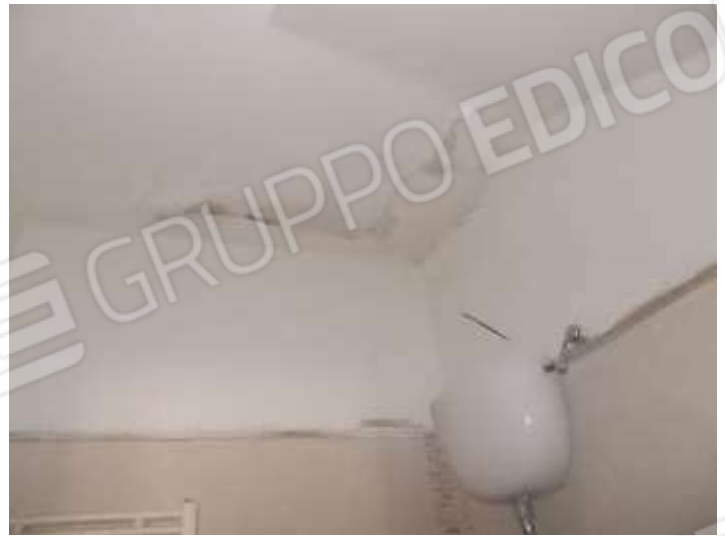
w.c. al piano terra si rilevano infiltrazioni provenienti dal primo piano
