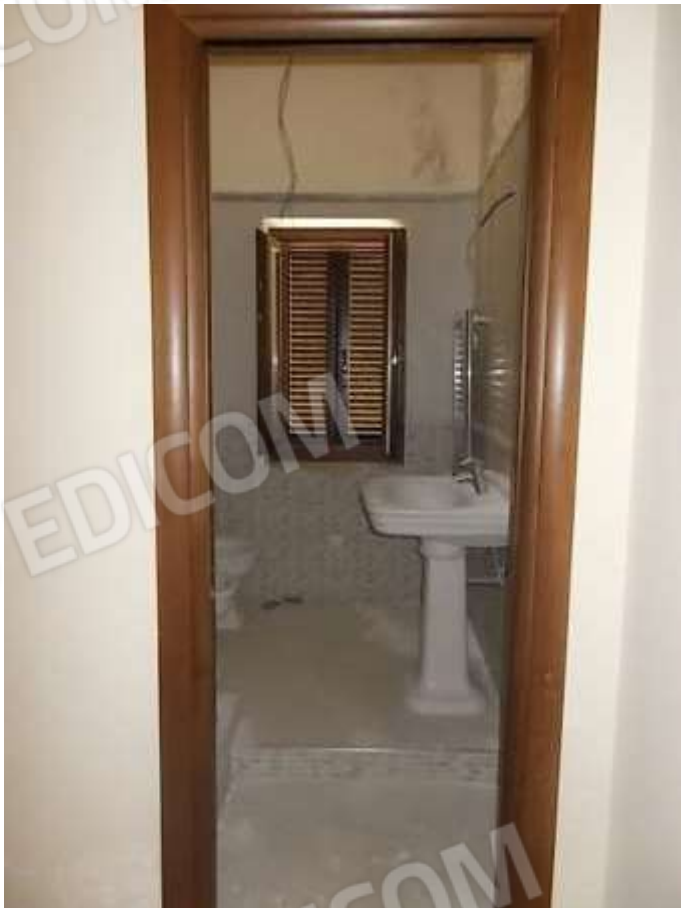
bagno al primo piano, si rilevano infiltrazioni provenienti dalla copertura
