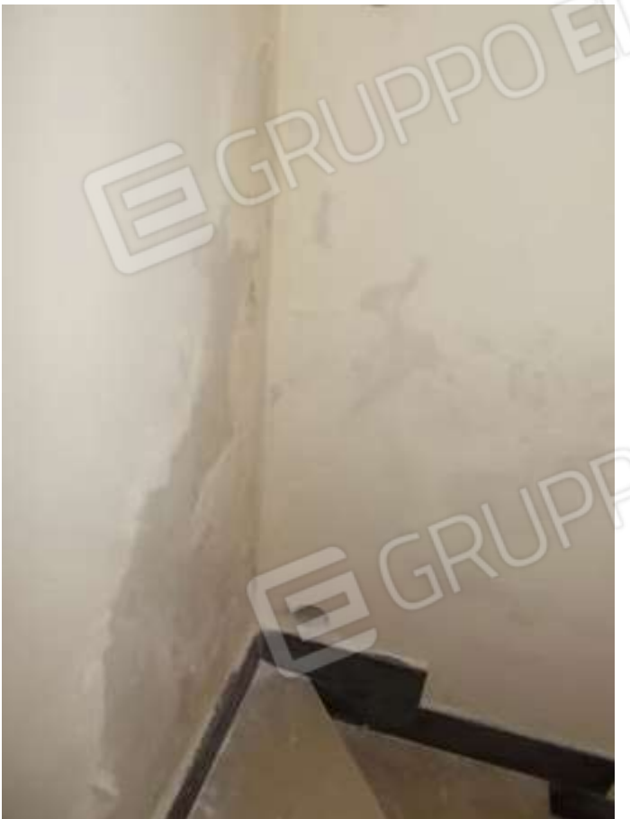
infiltrazioni al piano terra nella zona della scala provenienti dal muro di contenimento della strada
