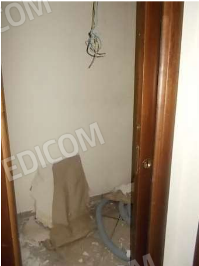
ambiente al primo piano con la ctrosoffittatura compromessa dalle infiltrazioni
