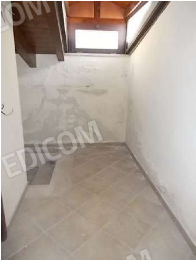
disimpegno ultimo piano compromesso dalle infiltrazioni provenienti dal muro di contenimento della strada
