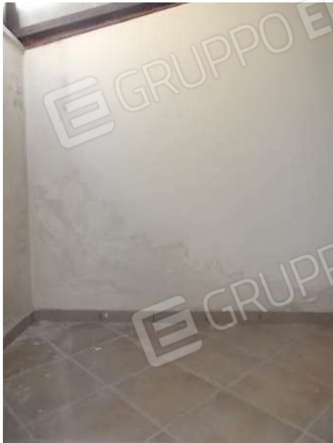
disimpegno ultimo piano compromesso dalle infiltrazioni provenienti dal muro di contenimento della strada
