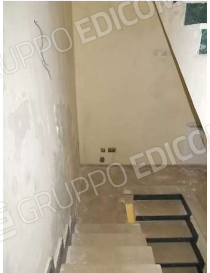
viste della scala con le infiltrazioni provenienti dal muro di sostegno della strada
