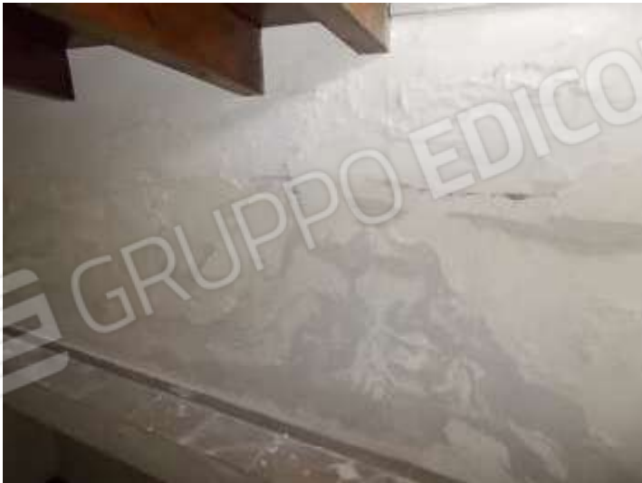
scala all'ultimo piano compromessa dalle infiltrazioni provenienti dal muro di contenimento della strada
