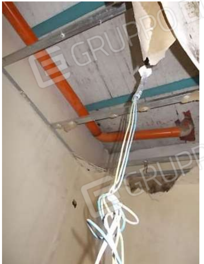
ambiente al primo piano con la ctrosoffittatura compromessa dalle infiltrazioni
