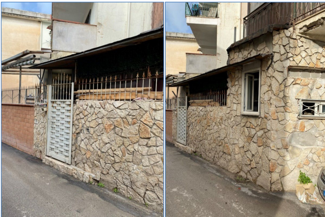
Figura 4. Prospetto sud fabbricato, ulteriore ingresso indipendente all'immobile pignorato da via Dentice.
