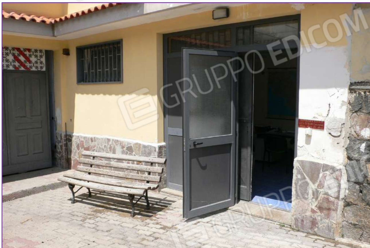
Foto n. 30 – Porta d'ingresso locale adibito ad ufficio
