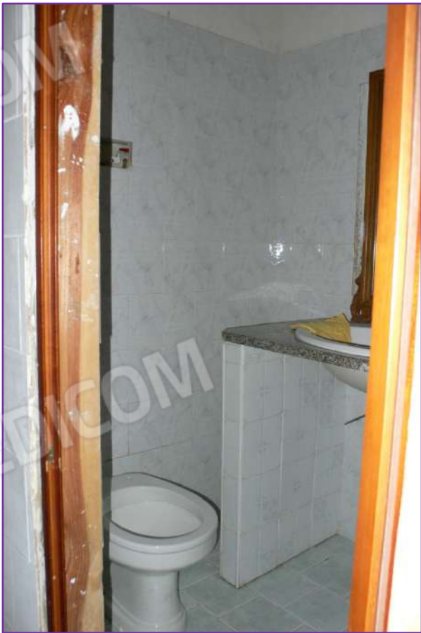
Foto n. 28 – Bagno 1 p. S1 (altra vista)
