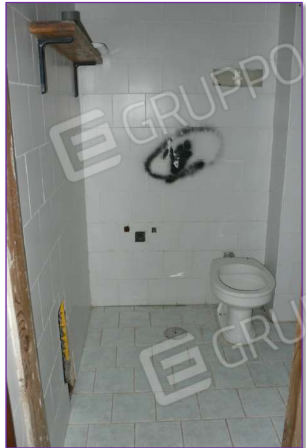
Foto n. 29 – Bagno 2 p. S1
