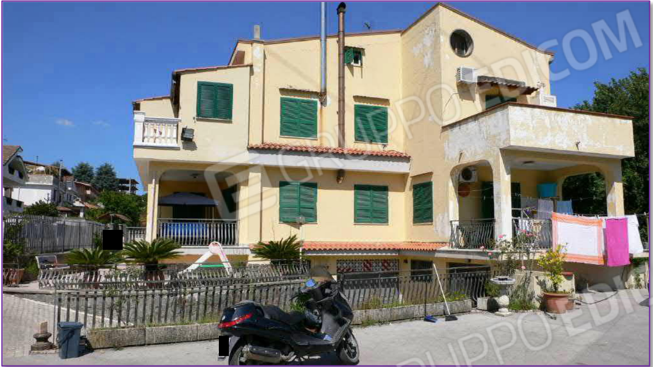
Foto n. 4 – Prospetto fabbricato lato est
