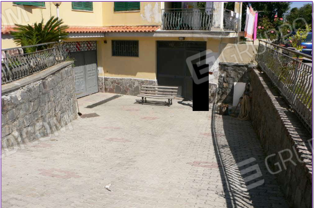
Foto n. 7 – Rampa d'accesso al piano seminterrato (ingressi locale garage e locale ufficio)
