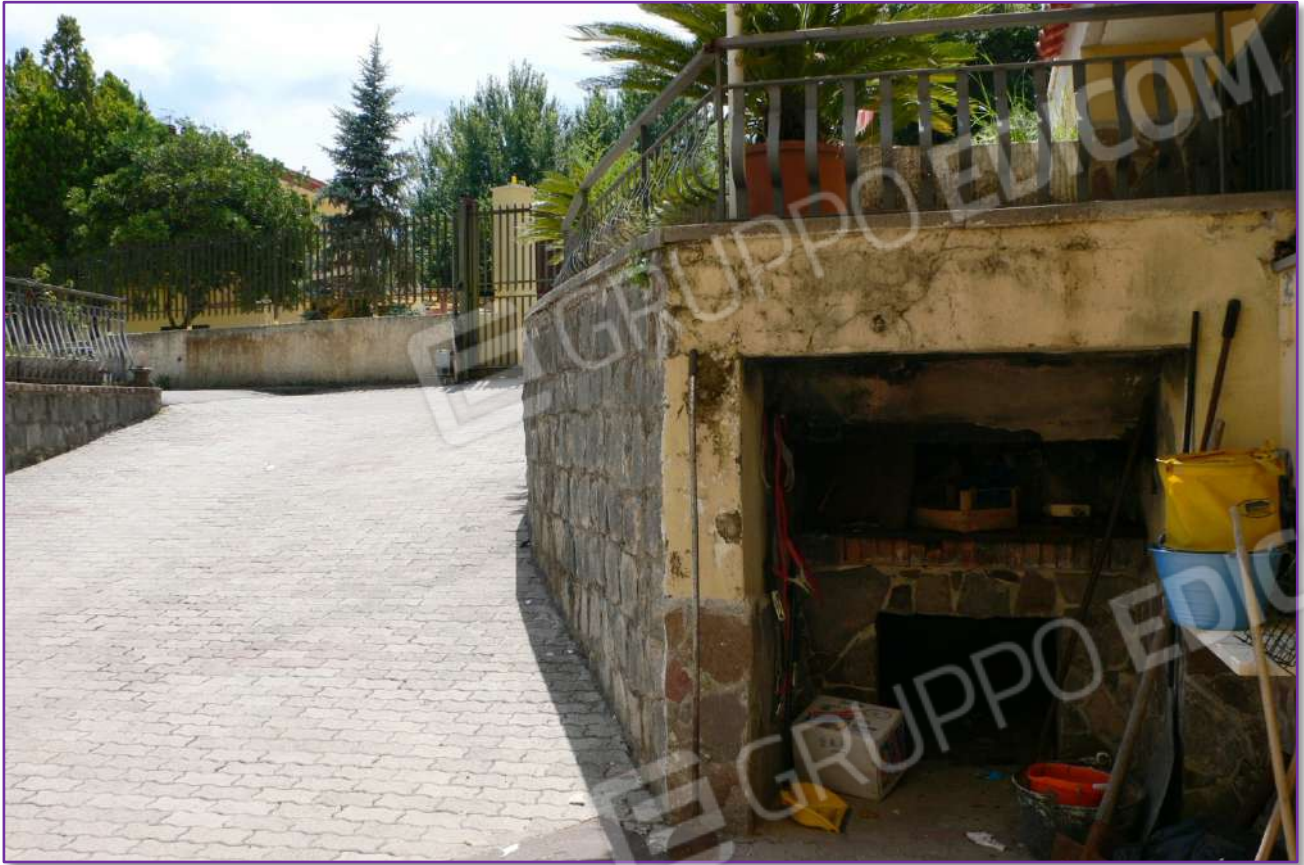
Foto n. 8 – Rampa (vista opposta)
