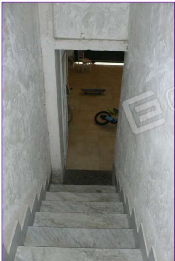
Foto n. 19 – Scala (seconda rampa)
