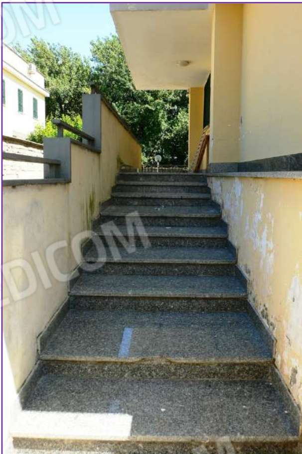
Foto n. 14 – Rampa scala accesso ingr. principale
