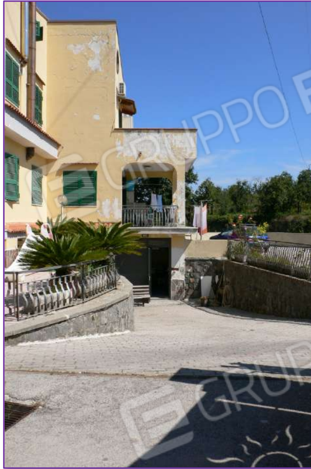
Foto n. 6 – Rampa d'accesso al piano seminterrato
