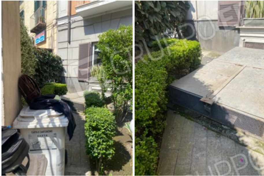
Foto 1: Vista vialetto ingresso e struttura in ferro con botola
