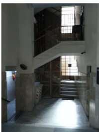
Foto 03 - Androne del fabbricato
