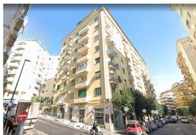
Foto 01 - Fabbicato dalla via G. Crisì
