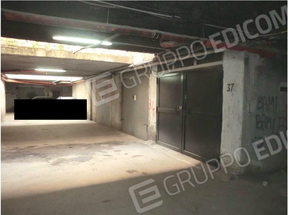
Foto 31: • Corridoio comune di accesso al box pignorato.
