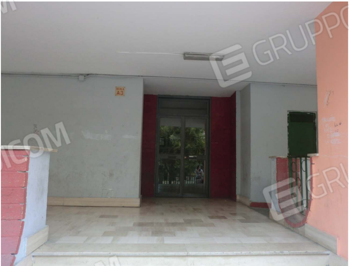
Foto 5: • Ingresso al fabbricato comprendente gli immobili pignorati (si noti la targa ai lati del portone).
