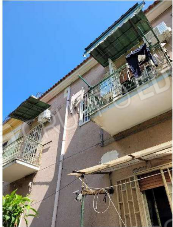
Facciata sul retro
