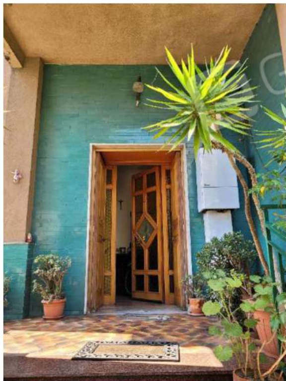
Terrazzo di ingresso sul fronte principale
