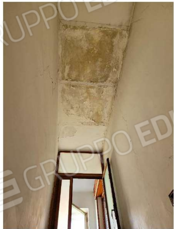
Particolare copertura vano scala
