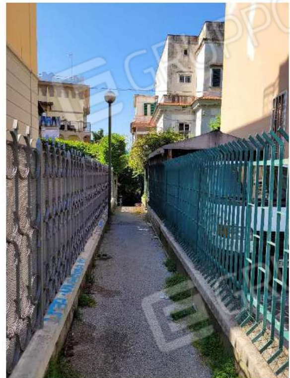
Strada pedonale che costeggia la costruzione pignorata
