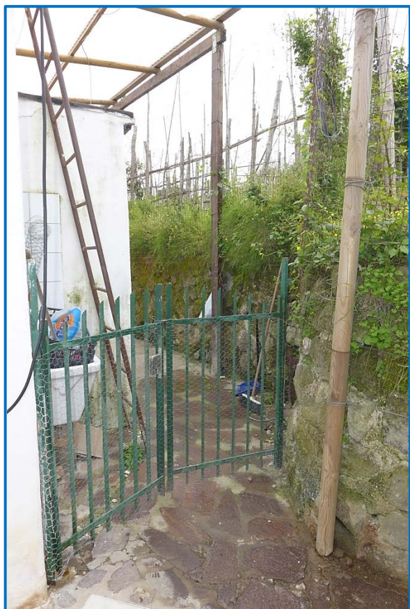
Foto n. 23 – Accesso area cortilizia retrostante
