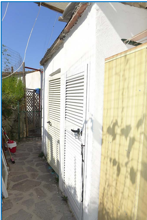
Foto n. 27 – Vani ripostiglio e lavanderia
