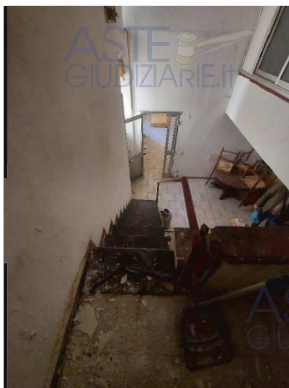
Disimpegno soppalco – vista su locale 1
