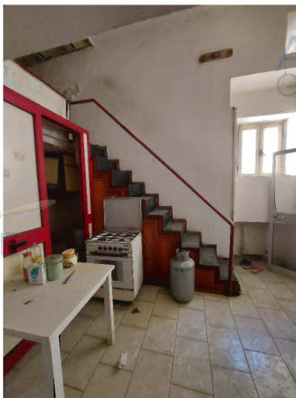
Locale 1 – rampa accesso soppalco
