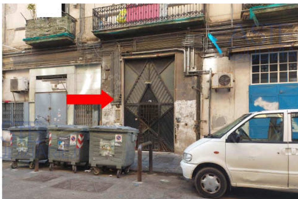
portone accesso fabbricato via via Milano n.40
