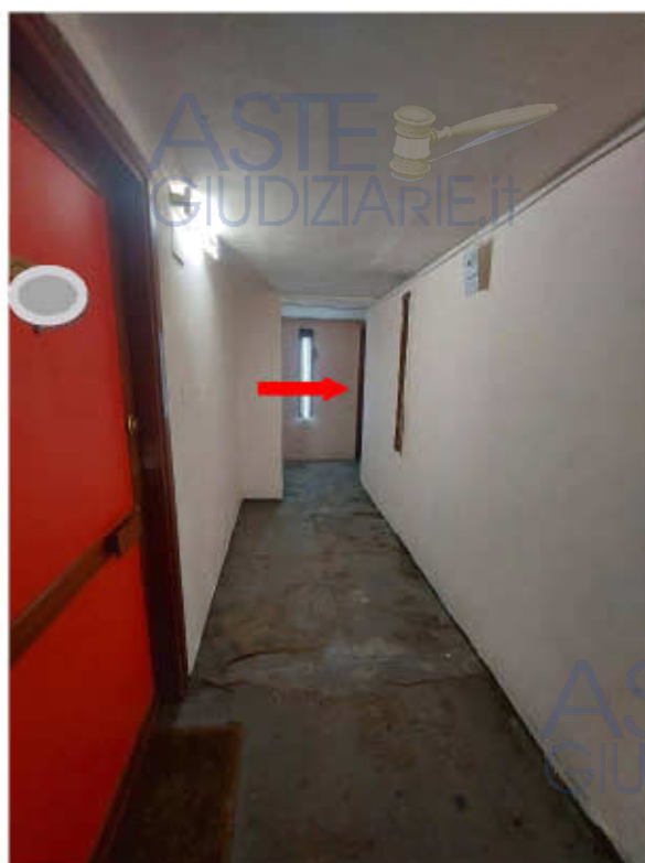
piano quarto pianerottolo comune - indicazione porta caposcala cespite
