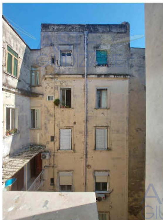
Finestra locale 2 - affaccio su cortile condominiale
