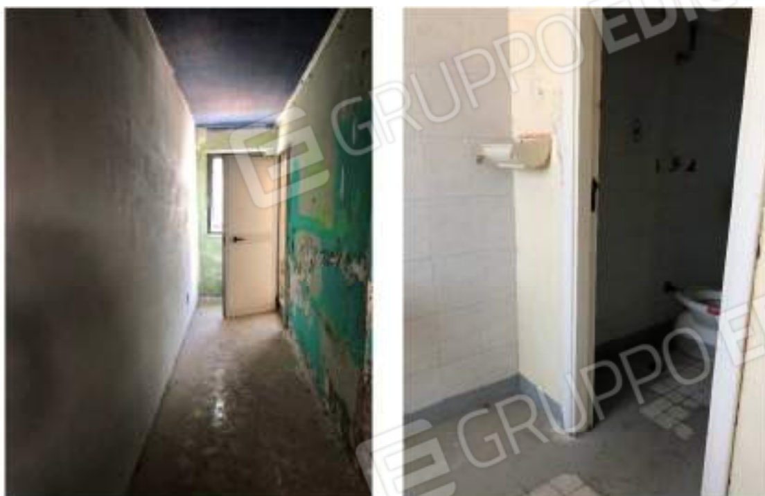
SUB 29 - Foto 5 e 6
