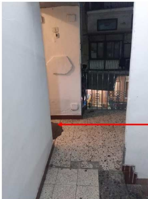
Foto n. 10 – Vano scala del fabbricato – ballatoio aperto di accesso all'immobile pignorato posto a sinistra
