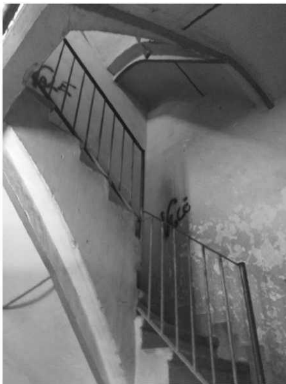
Foto n. 7 – Vano scala del fabbricato
