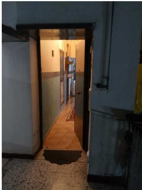
Foto n. 12 – Ballatoio aperto - accesso all’immobile pignorato
