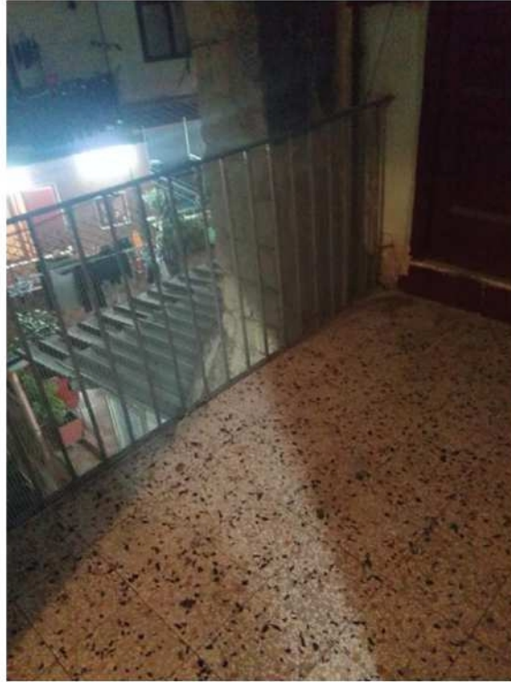
Foto n. 11 – Vano scala del fabbricato – ballatoio aperto di accesso all’immobile pignorato
