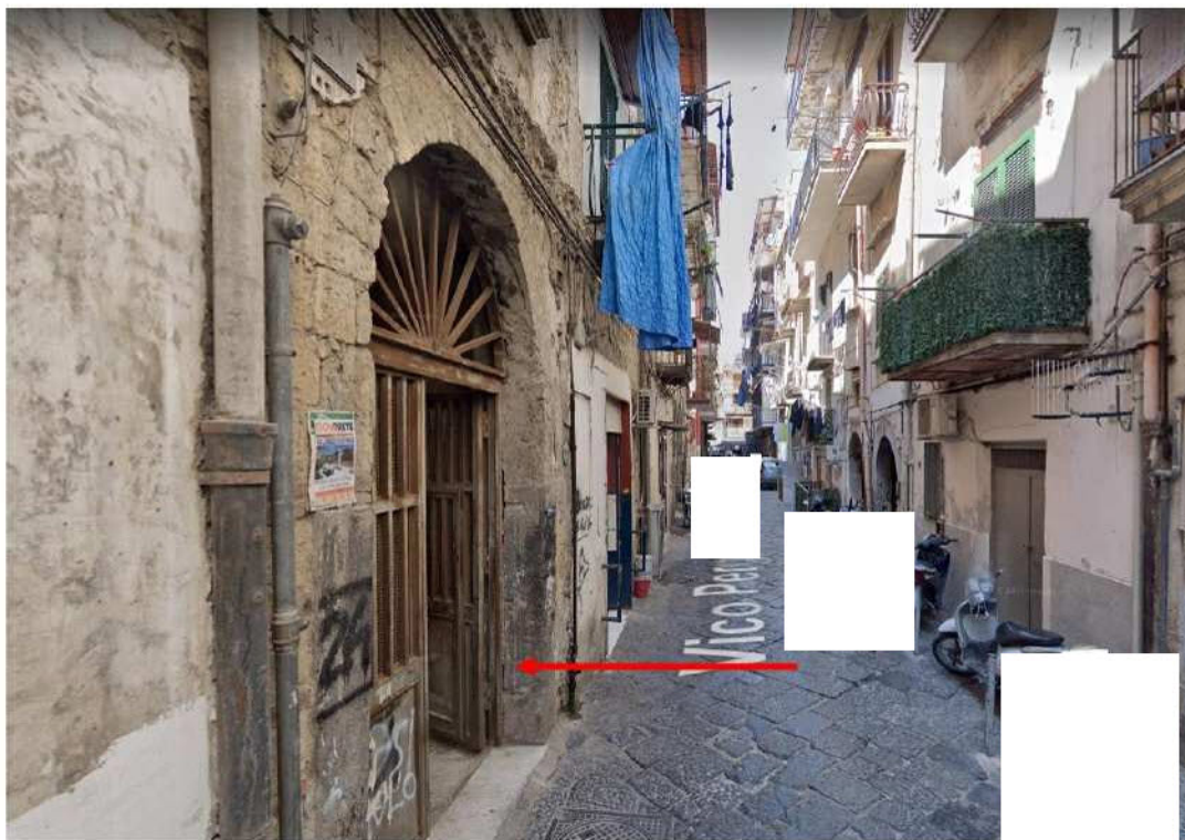
Foto n. 1 – Fabbricato in cui è ubicato l'immobile pignorato – vico Pergole n.24
