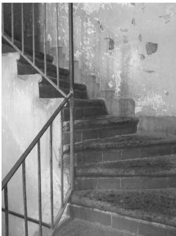
Foto n. 8 – Vano scala del fabbricato
