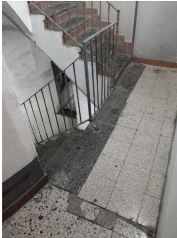
Foto n. 9 – Vano scala del fabbricato – pianerottolo comune al secondo piano
