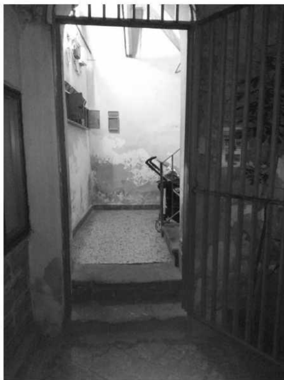
Foto n. 6 – Vano scala del fabbricato
