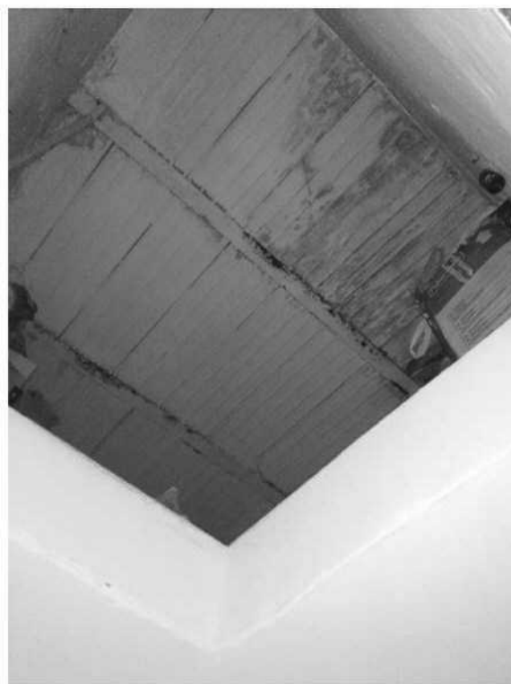
Foto n. 43 – Bagno – accesso al deposito in soppalco
