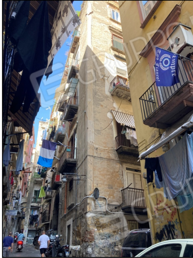
Foto n. 1: Fabbricato sito in Vico D'Afflitto n.28, Napoli
