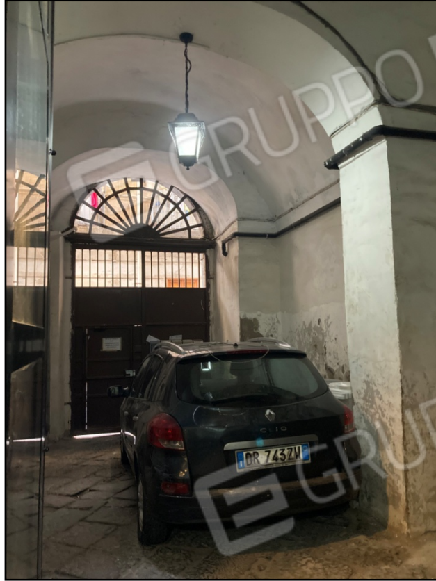
Foto n. 5: Fabbricato Vico D'Afflitto n.28, Napoli – androne
