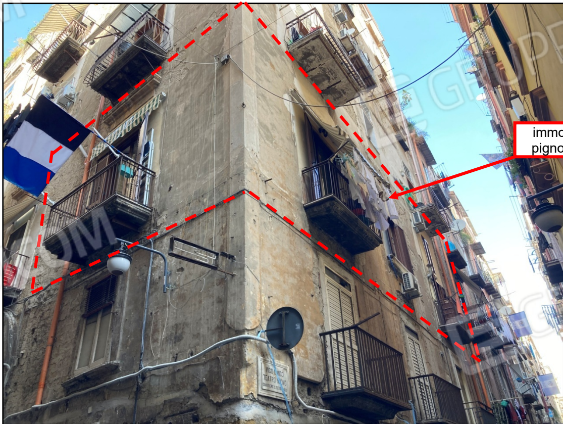
Foto n. 2: Fabbricato Vico D'Afflitto n.28, Napoli e immobile pignorato
