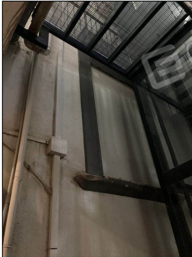
Foto n. 14: Immobile pignorato – vista dal cortile della finestra chiusa
