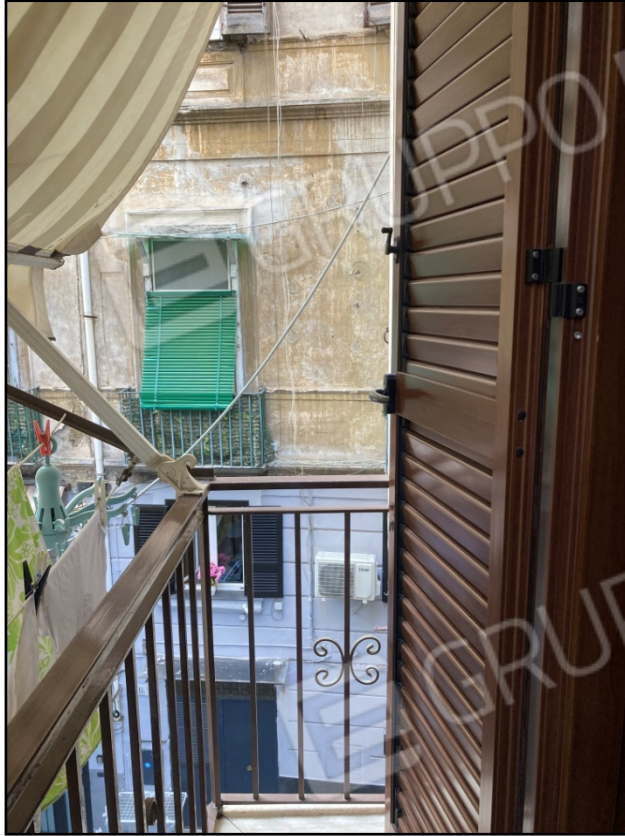
Foto n. 21: Immobile pignorato – balcone n.2 afferente la camera n.1
