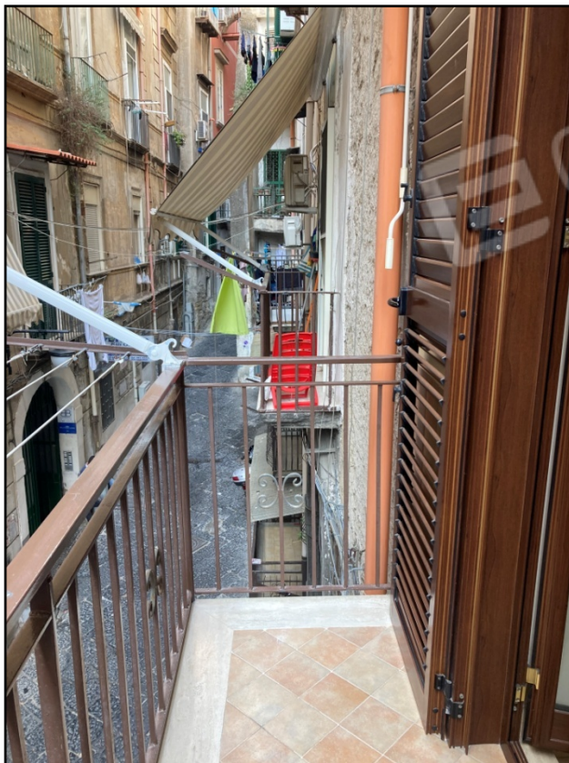
Foto n. 22: Immobile pignorato - balcone n.3 afferente la camera n.1
