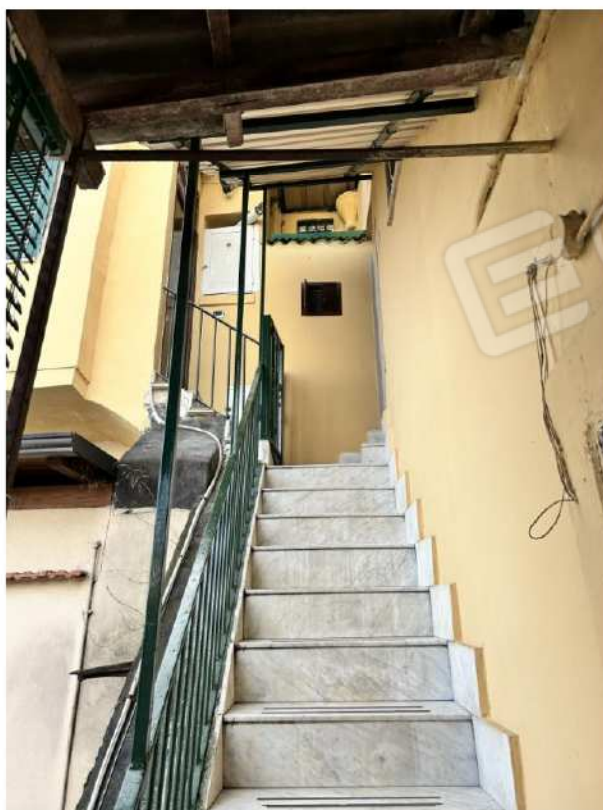
Foto n. 5 – Rampa scala di accesso
