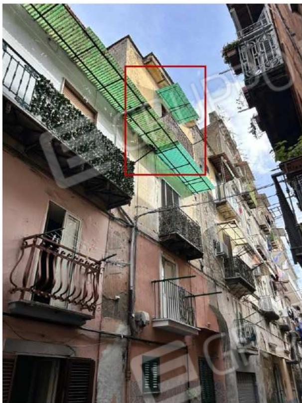
Foto n. 1 – Fabbricato in cui è ubicato l'immobile pignorato
