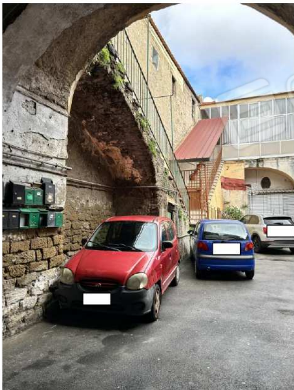
Foto n. 2 – Cortile e rampa scala di accesso
