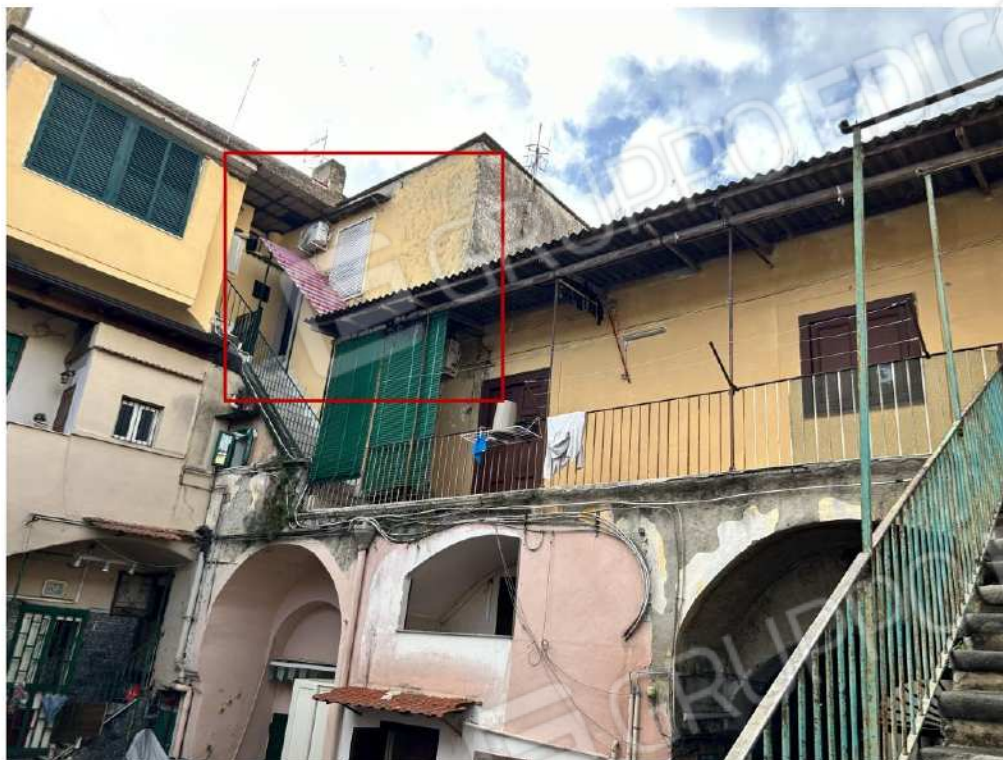
Foto n. 4 – Cortile rampa scala e ballatoio di accesso
