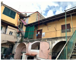
Foto n. 4 - Cortile rampa scala e ballatoio di accesso
