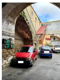
Foto n. 2 - Cortile e rampa scala di accesso
