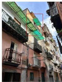
Foto n. 1 - Fabbicato in cui è ubicato l'immobile pignocato
