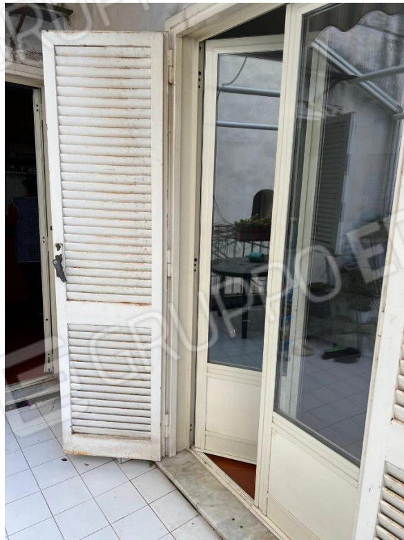
Foto n. 25 – balcone di accesso al terrazzo dal tinello
