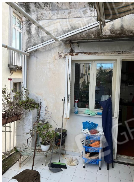
Foto n. 26 – balcone di accesso al terrazzo dalla cucina
