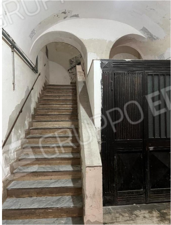
Foto n. 3 – prima rampa del vano scala al piano terra
