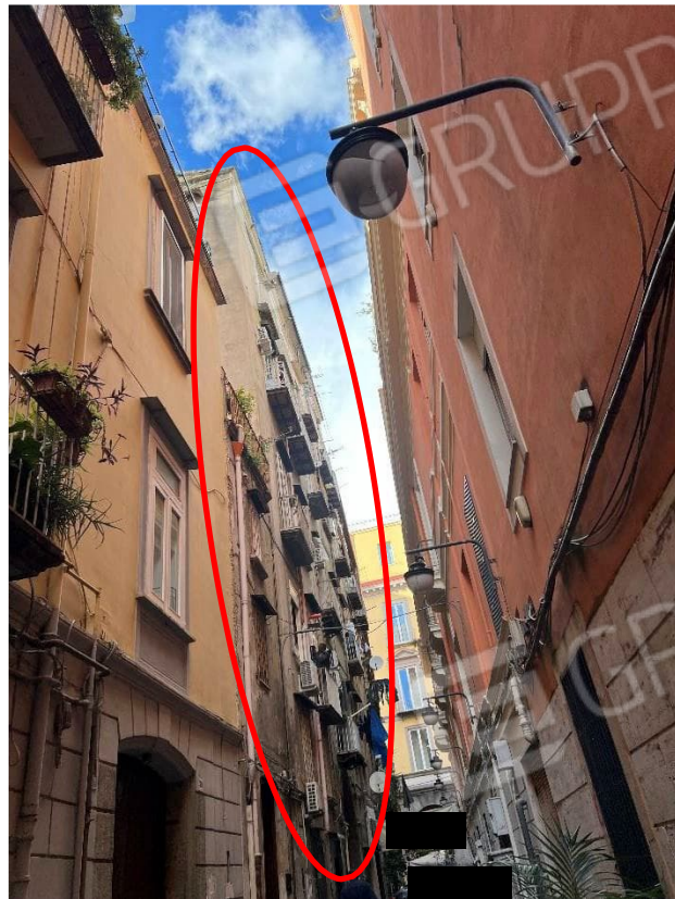
Foto n. 2 – facciata fabbricato civico 34 su Vico dei Corrieri
