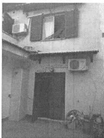
Terrazzo senza affaccio su strada del sub.108
