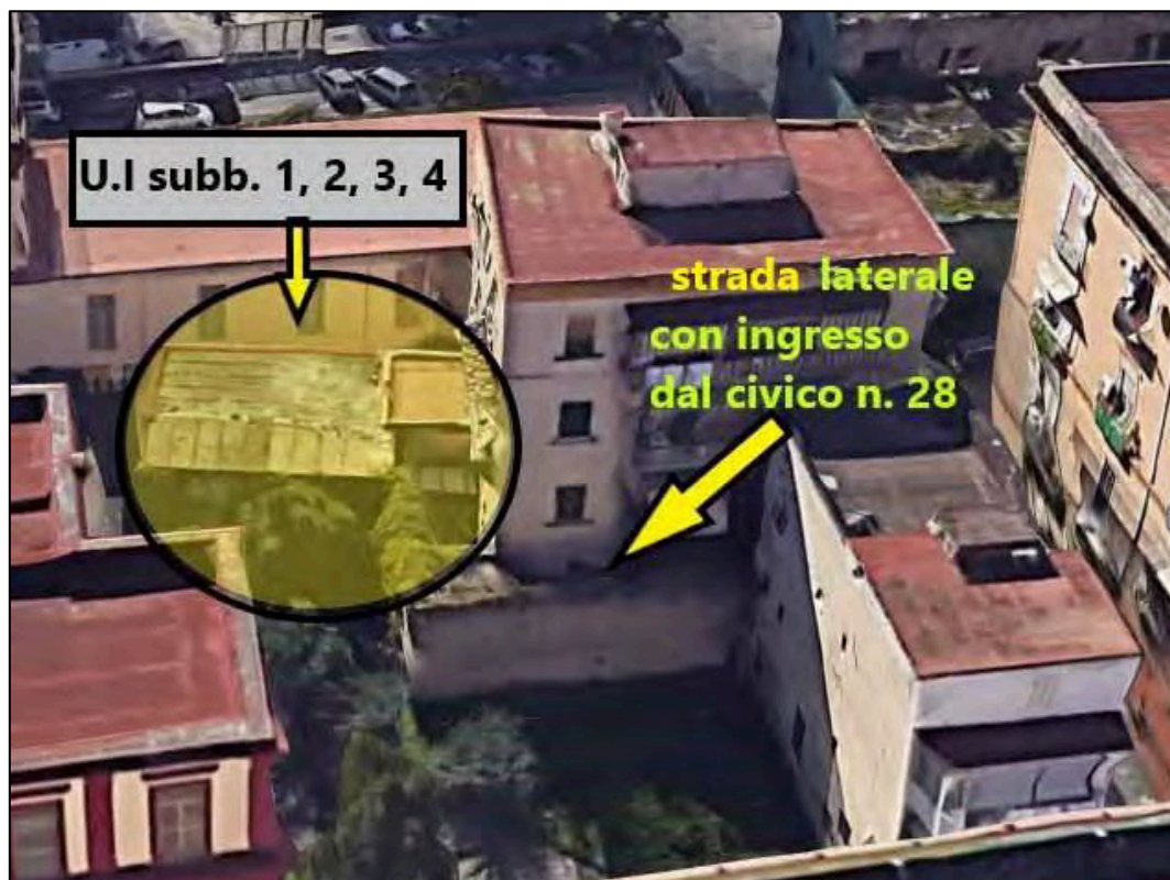
Foto 3, Accesso ai sub. 2, 3, 4 dalla strada laterale con ingresso dal civico n. 28 di via S.M. delle Grazie a Loreto.
