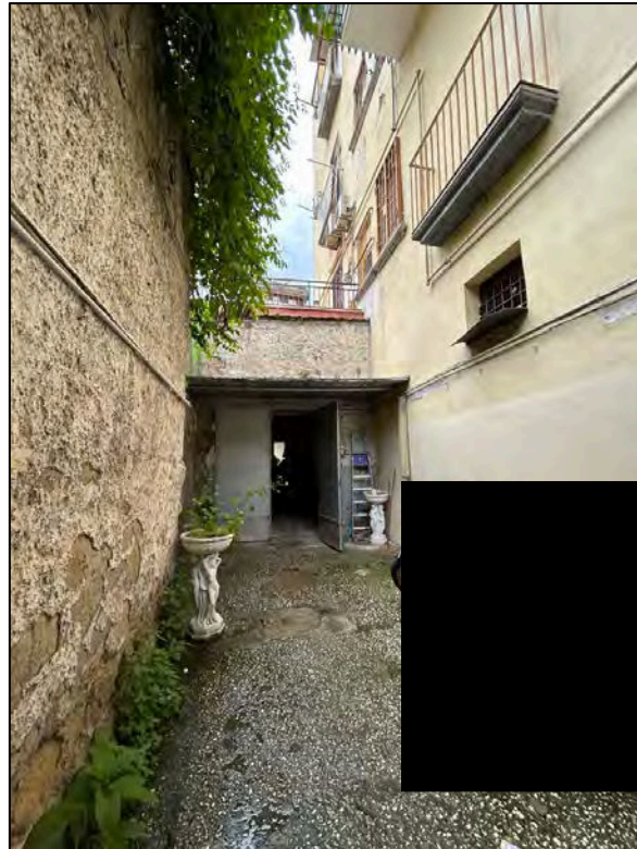
Foto 6, Strada laterale con ingresso dal civico n. 28 di via S.M. delle Grazie a Loreto.
