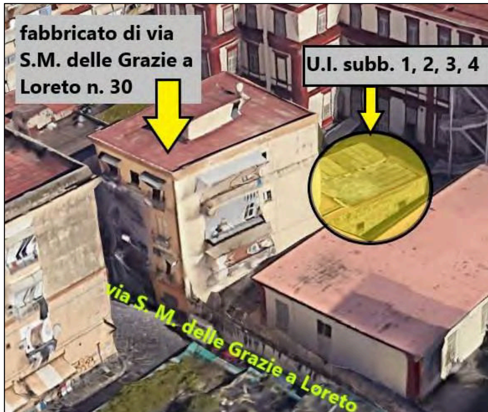
Foto 2, Il fabbricato di via S.M. delle Grazie a Loreto 30 con l'individuazione dei sub. 2, 3, 4
