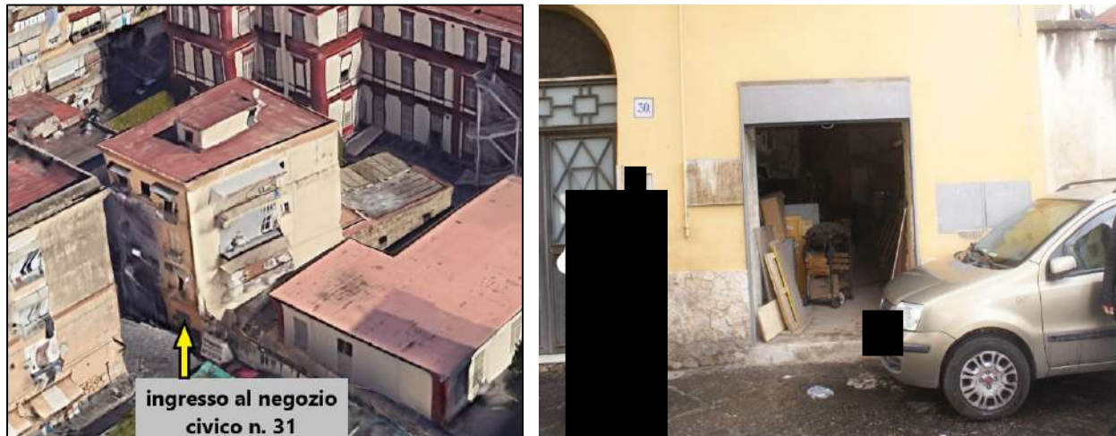
Fig. 2a, 2b Il fabbricato di via Santa Maria delle Grazie n.30 con l'individuazione dell'ingresso al negozio civico 31
