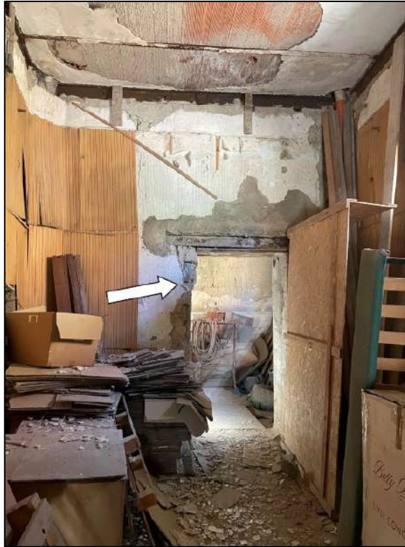
Stanza 2: foto tratta dalla relazione dell'ing. [REDACTED] vista seconda stanza con muro dissestato piattabanda e detriti solaio a terra
