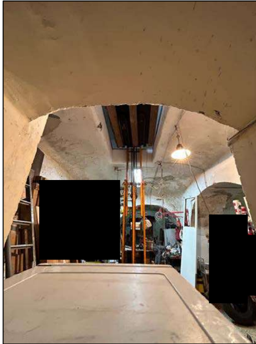
Stanza n. 5: in primo piano il montacarichi, sulla destra l'arco di comunicazione con la stanza 6 e sul fondo l'arco di comunicazione con il vano di proprietà aliena.
