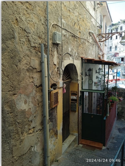
Facciata esterna fabbricato
