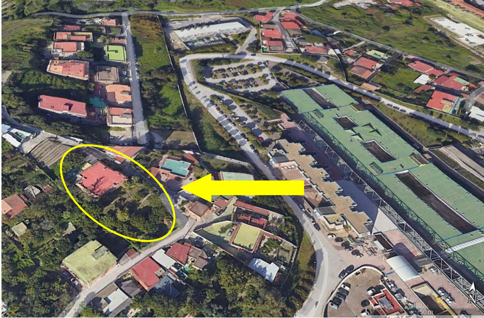
Vista aerea del fabbricato di via Vicinale detta dell'Infermeria n. 71
