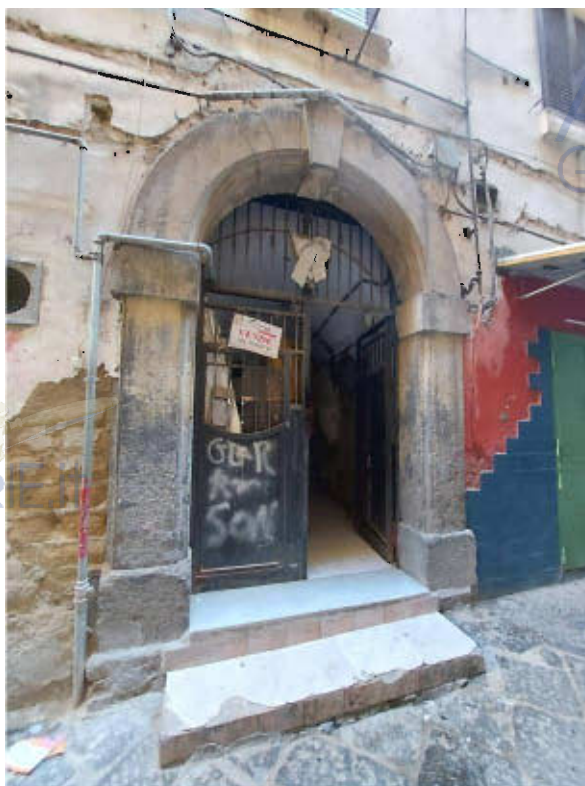
portone accesso fabbricato cespite
