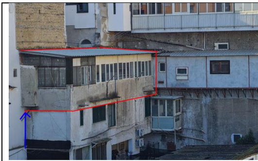
Foto 06 – L'ampliamento visto esternamente
