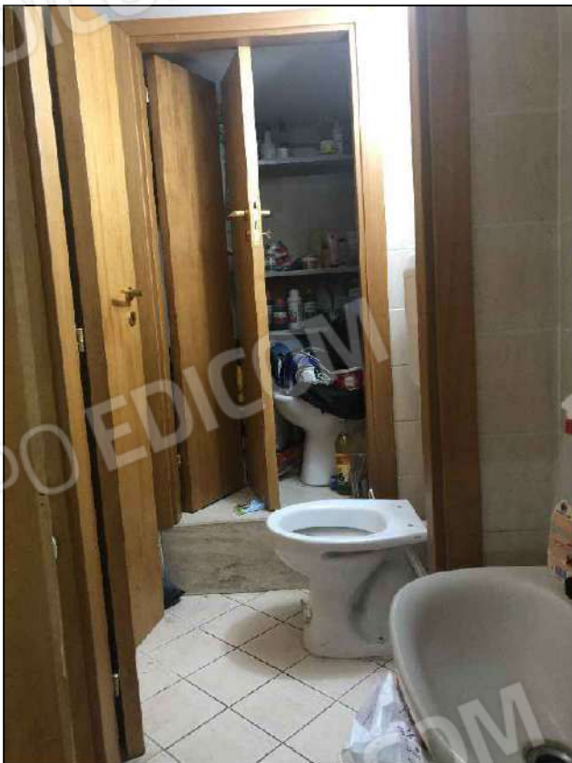
FOTO 14 - W.C. SUB I39
