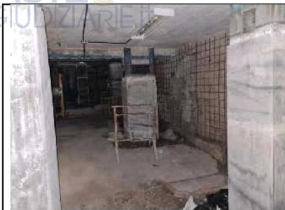
*foto 25 – Interventi di rinforzo tipo "beton plaquet" sui pilastri **NON** portato a termine.*
