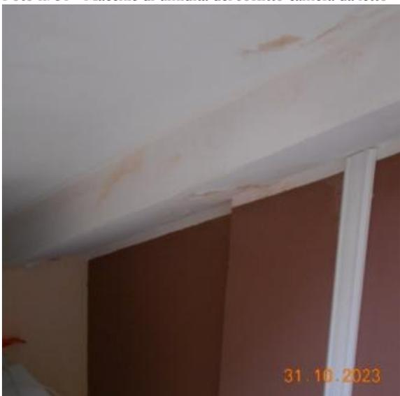
Foto n. 52 - Macchie di umidità del soffitto del bagno
