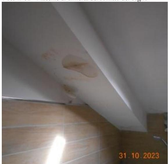
Foto n. 53 - Cartongesso a copertura delle macchie di umidità
