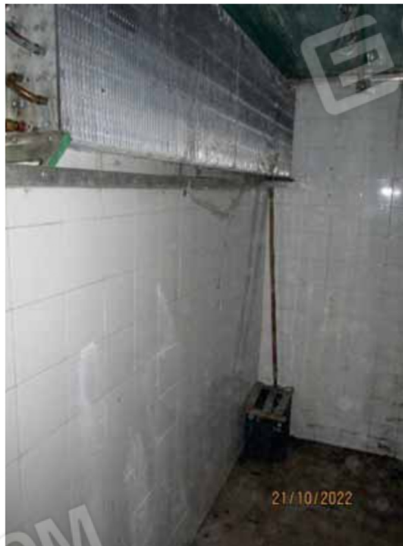
Fotografia 22 – Locale 1 Sub 101: Il locale non dispone di finestre ed è dotato di un apparato frigo ormai in disuso.
