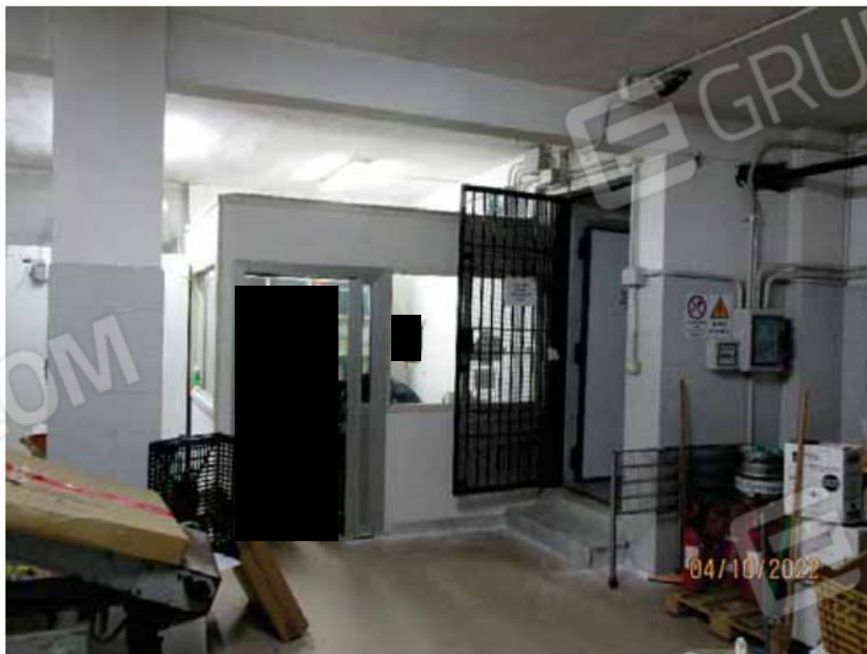
Fotografia 24 – Locale 2/a Sub 102 : Il locale occupa una superficie utile calpestabile pari a mq. 106,96 e un'altezza interna dal piano di calpestio pari a ml. 3,10.
