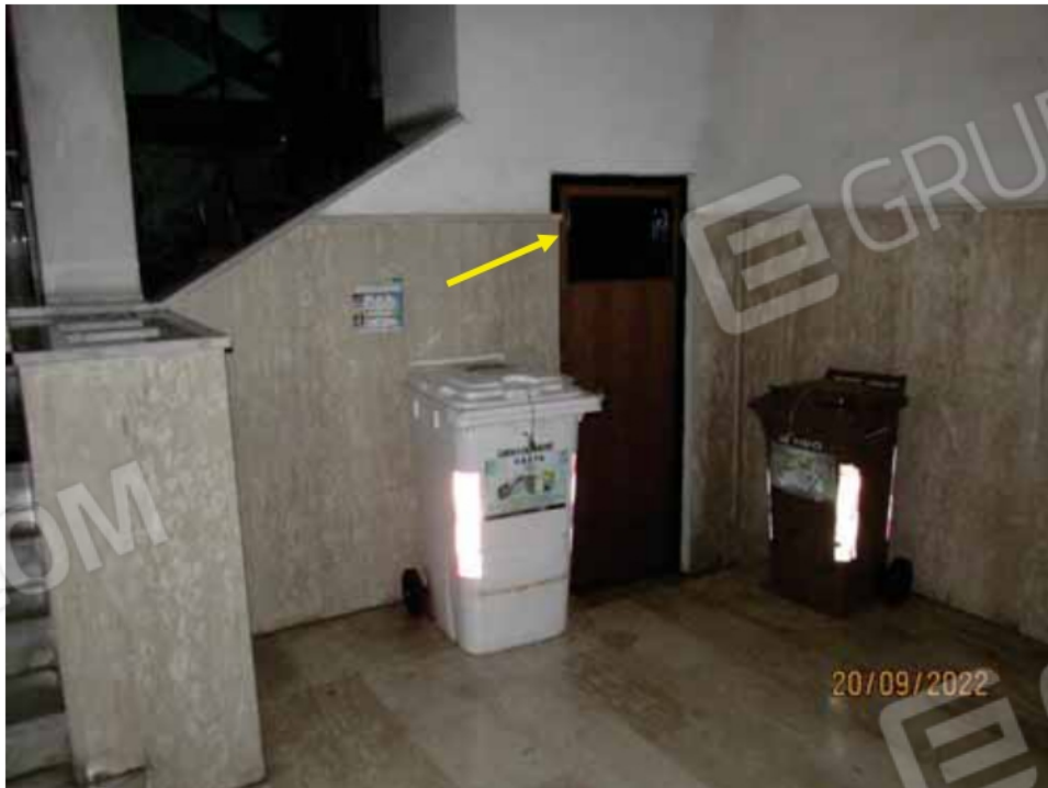
Fotografia 14 – I locali ad uso deposito posti al piano interrato del fabbricato, sono accessibili tramite un piccola scala protetta all'accesso, da una porta in ferro posta in fondo a sinistra per chi entra nell'androne.
