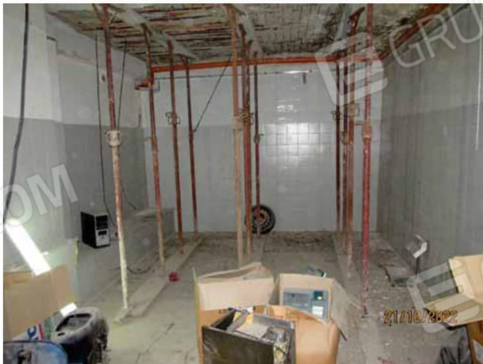
Fotografia 36 – Locale 2/b Sub 102 : Il locale occupa una superficie calpestabile utile netta pari a mq. 32,64 e un'altezza dal piano di calpestio pari a ml. 3,15. La pavimentazione è interamente costituita da piastrelle in ceramica; le pareti risultano in parte rivestite con piastrelle in ceramica smaltata e in parte risultano rivestite con intonaci ordinari a finitura liscia e tinteggiate con pittura lavabile.
