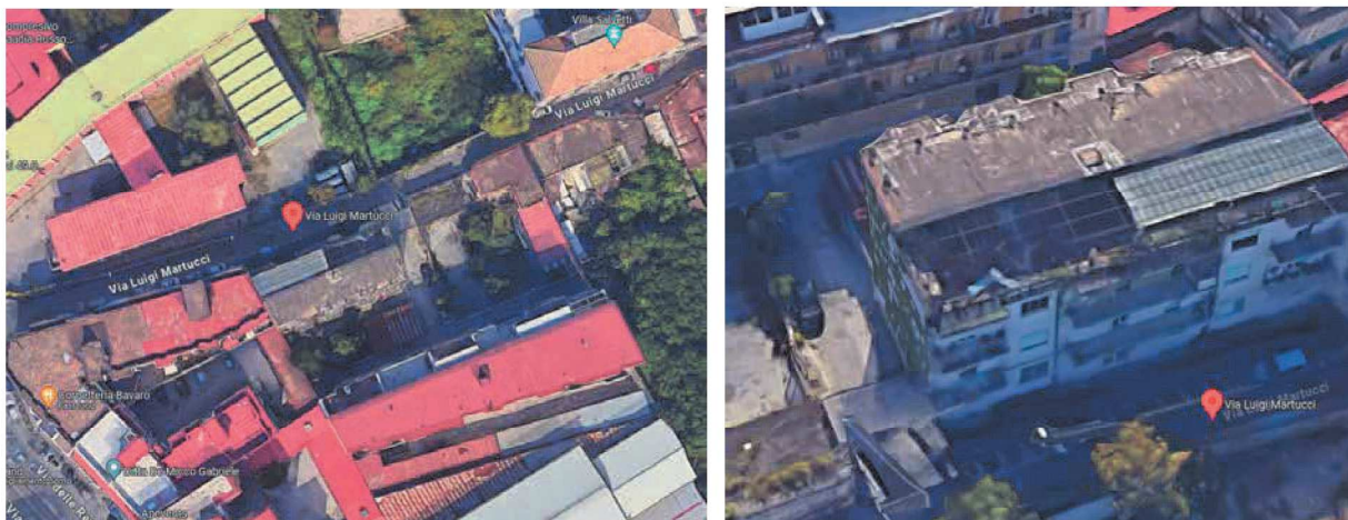
Viste aeree del fabbricato sito in Napoli alla via Luigi Martucci n. 50
