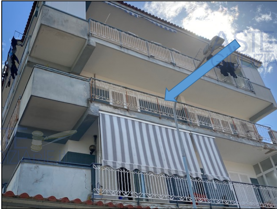
Figura 1: fronte su Viale privato si individua l'immobile pignorato
