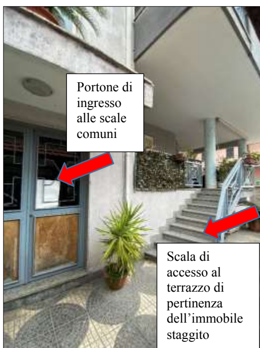
individuazione dell'accesso al fabbricato
