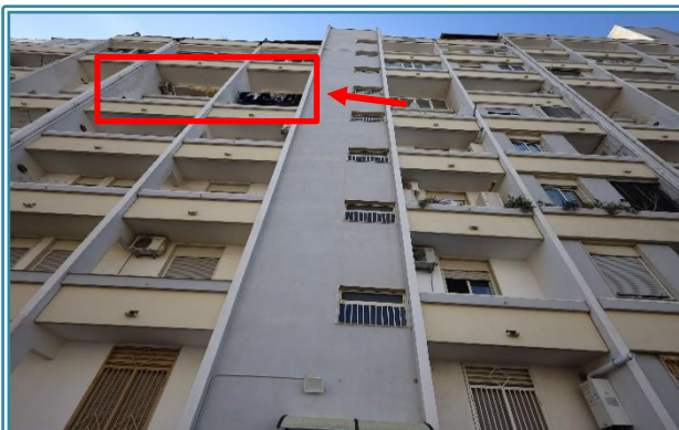
Figura 12 Facciata edificio prospetto est
