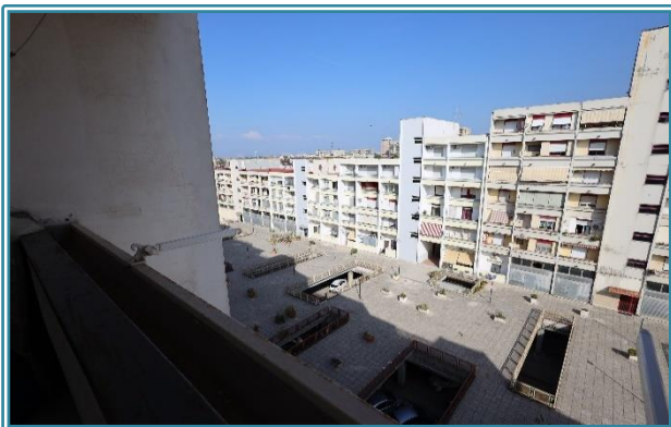
Figura 26 Vista su cortile interno
