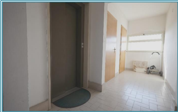
Figura 14 Ascensore con locali condominiali
