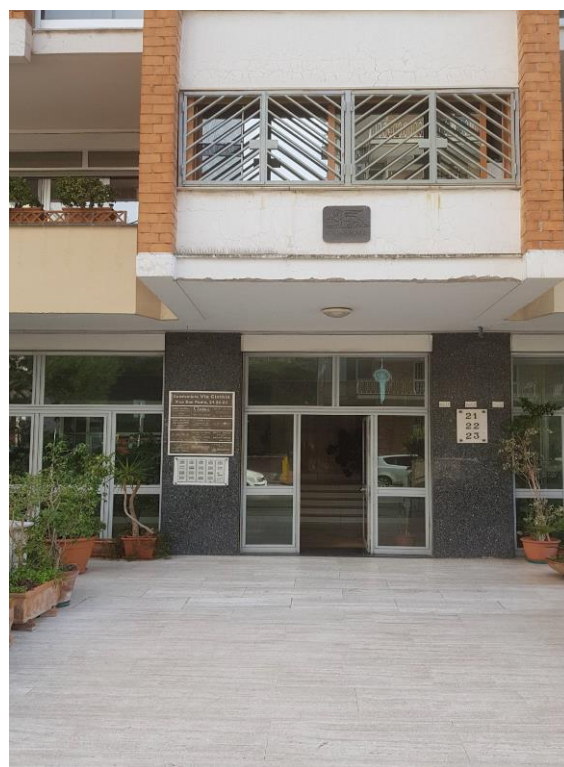
Vista cancello di accesso
