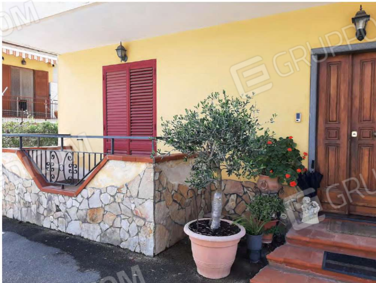
Foto 4 – Porta d'ingresso all'unità immobiliare ad uso abitativo
