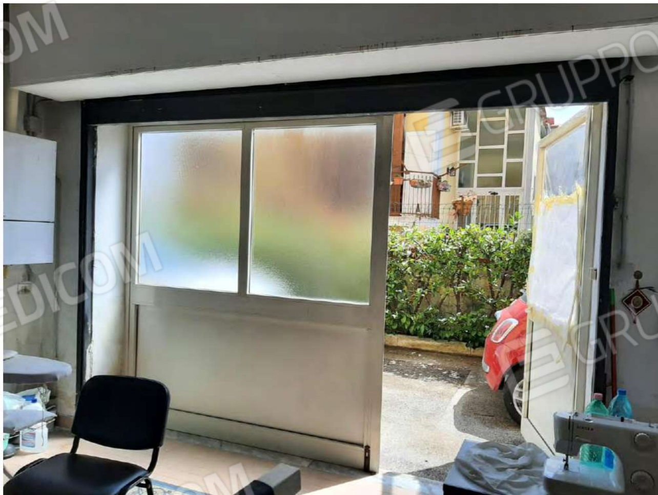
Foto 26 – Portone di accesso al locale al piano terra (garage)
