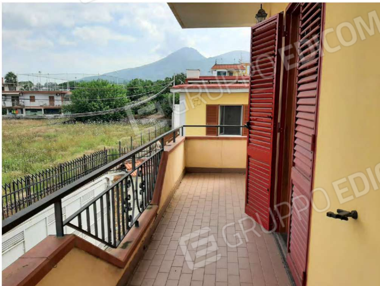
Foto 21 – Balcone al piano primo con esposizione a nord
