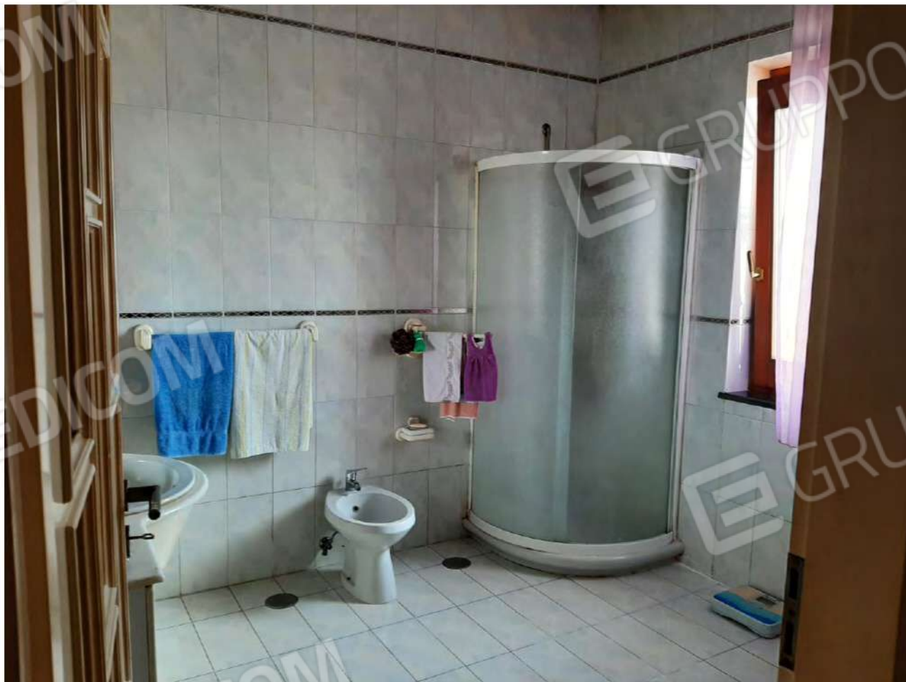
Foto 12 – Bagno del piano terra
