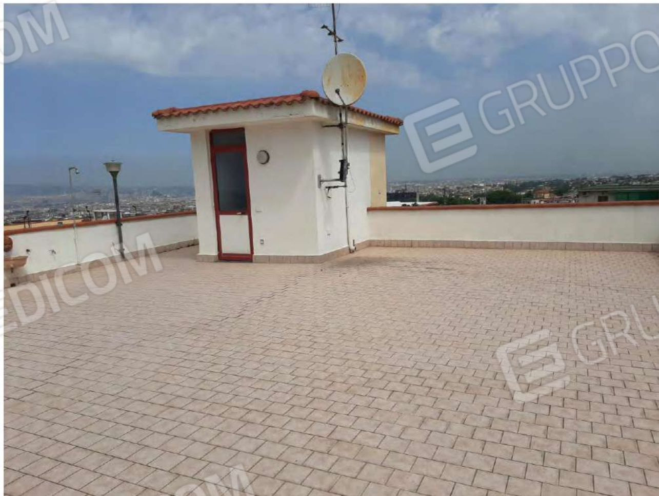
Foto 24 – Terrazzo di copertura
