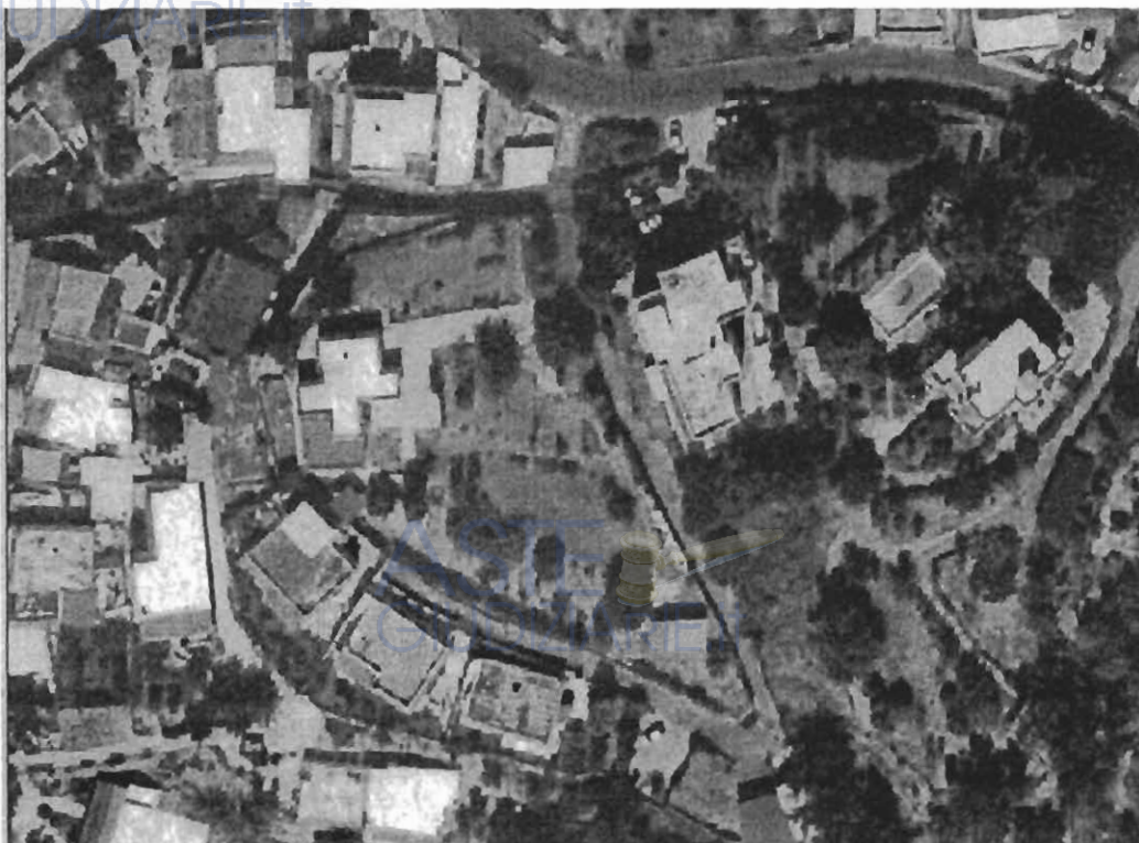
Levata aerea settembre 2004
