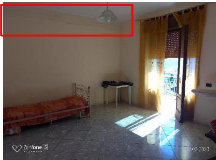
(Fig. 20 discostamento intonaco camera n. 02)
