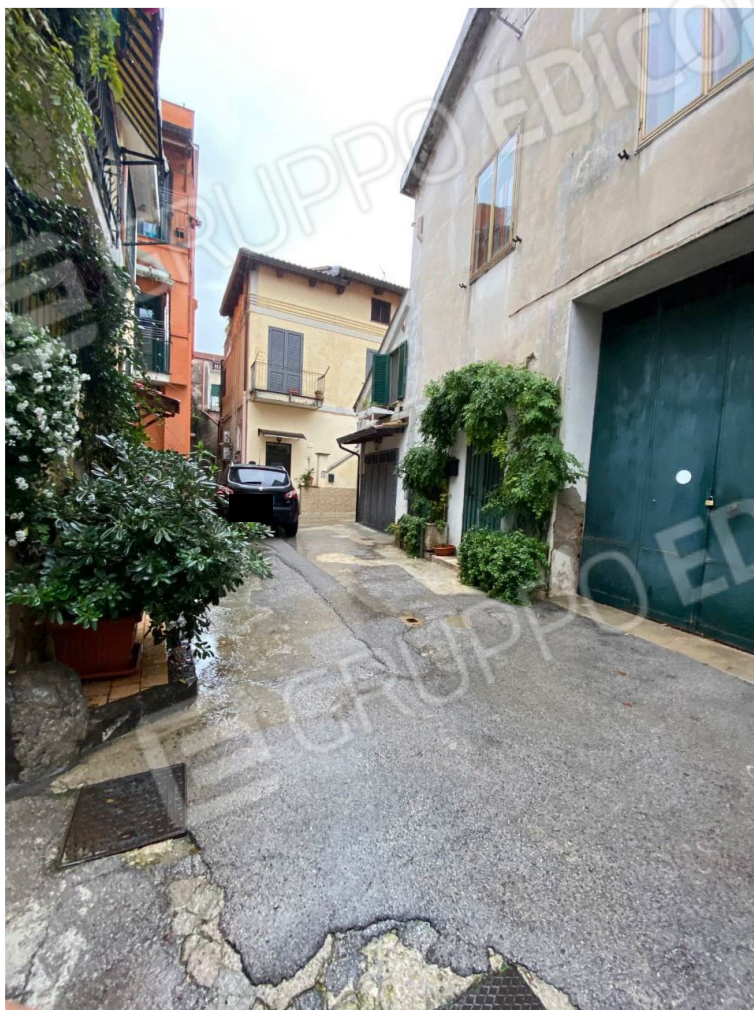
Vista dell'edificio dall'imbocco della traversa di via Sabato Celano
