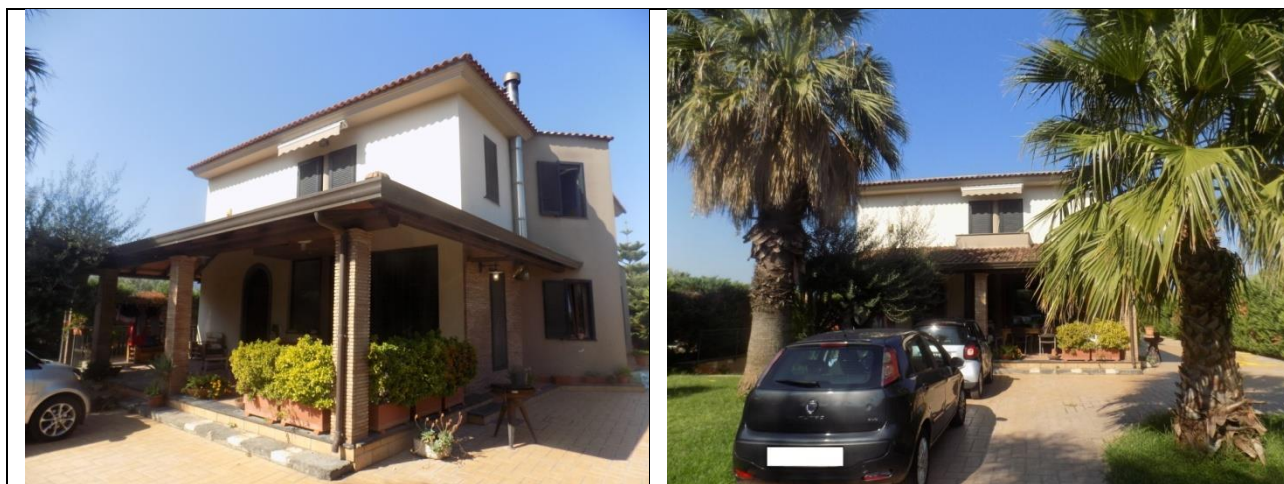
Localizzazione dell'immobile suddiviso su tre livelli di cui due fuori terra, con area pertinenziale contraddistinta dalla Part. 2989 (non esplicitamente pignorata ma accessione pertinenziale al manufatto della villa)
