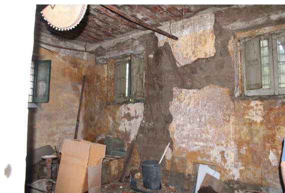
Figura 8 – Interno negozio – Lato Nord-Est
