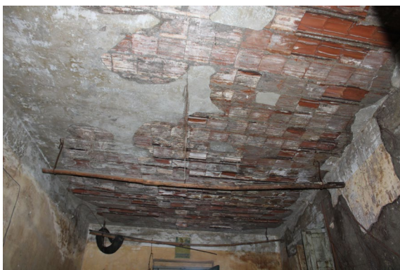
Figura 9 – Interno negozio – Succielo crollato
