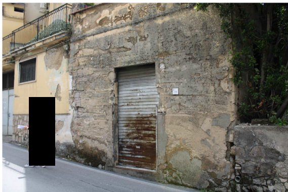
Figura 5 – Accesso negozio dalla strada
